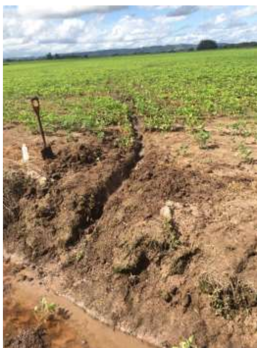
Figura 4. Micro dreno construído em áreas alagadas.
