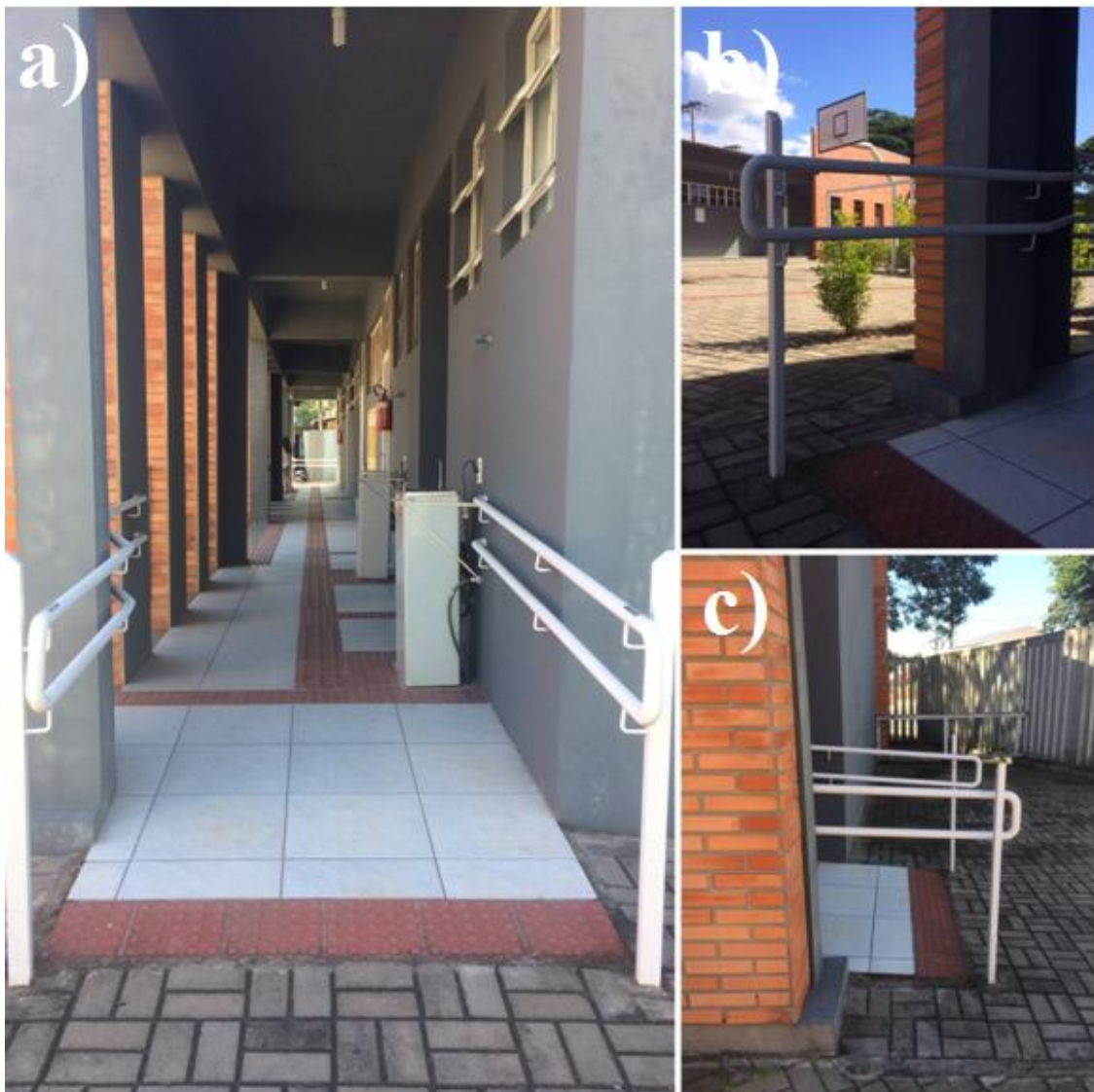
Figura 46 - a) Saída do corredor principal; b) Corrimão de duas alturas, lateral esquerda; c) Corrimão de duas alturas, lateral direita
