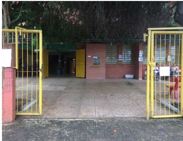
Figura 31 - Entrada principal da escola cujo piso foi executado com revestimento cerâmico
