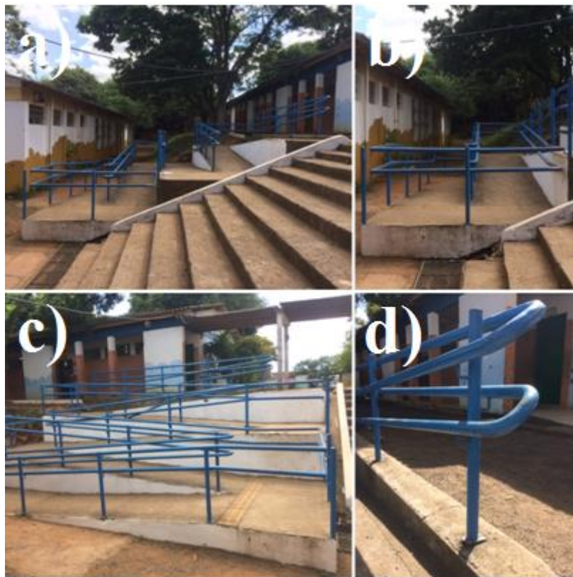
Figura 55 - a) Vista lateral dos segmentos cinco segmentos de rampa; b) Vista aproximada dos patamares da rampa; c) Vista frontal dos cinco segmentos de rampa; d) Corrimão de duas alturas
