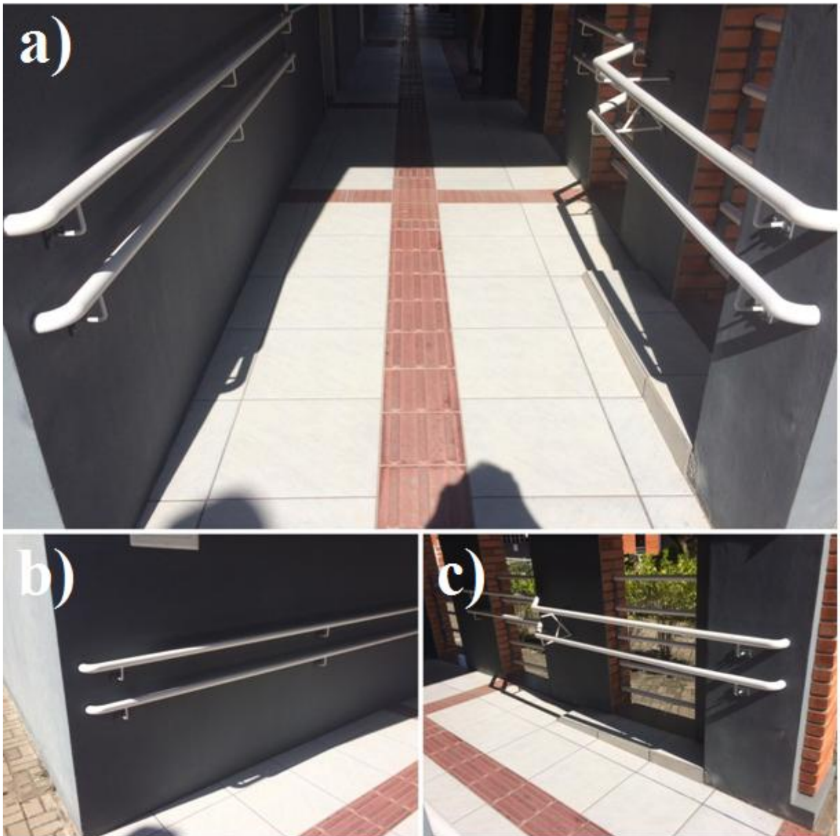
Figura 45 - a) Vista frontal do corredor de entrada; b) Corrimão de duas alturas, lateral esquerda; c) Corrimão de duas alturas, lateral direita.
