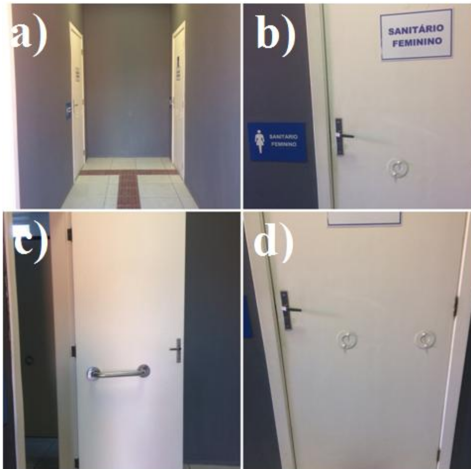
Figura 47 - a) Vista frontal do corredor do sanitário; b) Porta de entrada do sanitário acessível; c) Porta de entrada do sanitários acessível com puxador horizontal; d) Maçaneta do tipo alavanca
