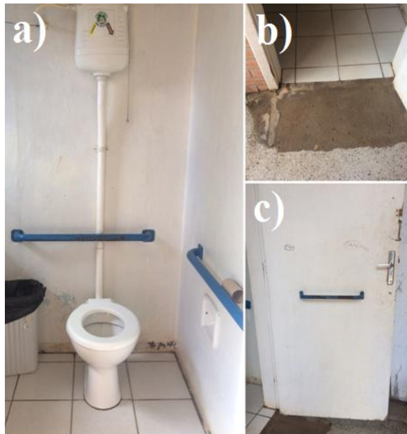
Figura 57 - a) Vista frontal do sanitário acessível; b) Revestimento cerâmico do sanitário; c) Porta de entrada do sanitário
