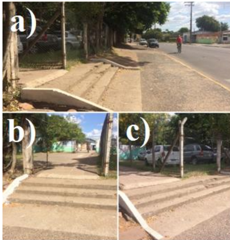
Figura 53 - a) Calçada da escola; b) Vista frontal da escada do acesso principal; c) Vista lateral do acesso principal
