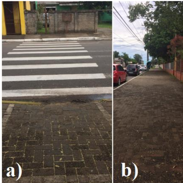
Figura 30 - a) Rebaixamento de calçada para acesso dos alunos cadeirantes; b) Calçada da escola
