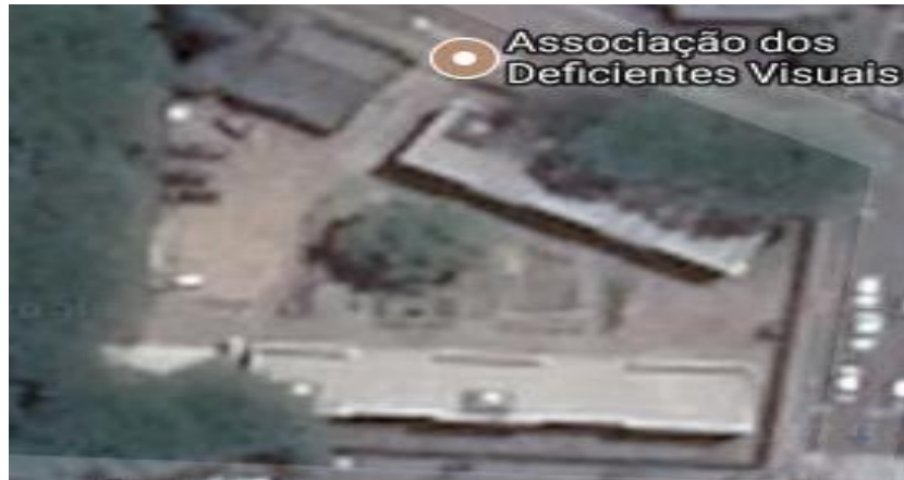
Figura 41 - Vista aérea da edificação
