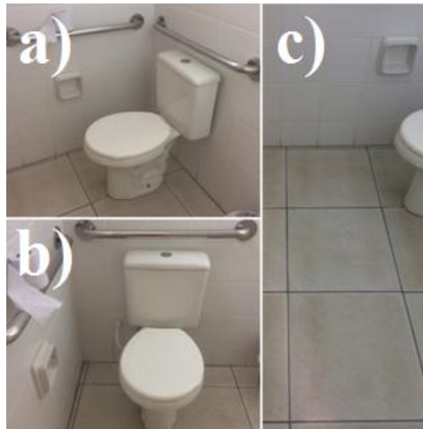
Figura 48 - a) Bacia sanitária do tipo caixa acoplada; b) Vista frontal da bacia sanitária; c) Revestimento cerâmico
