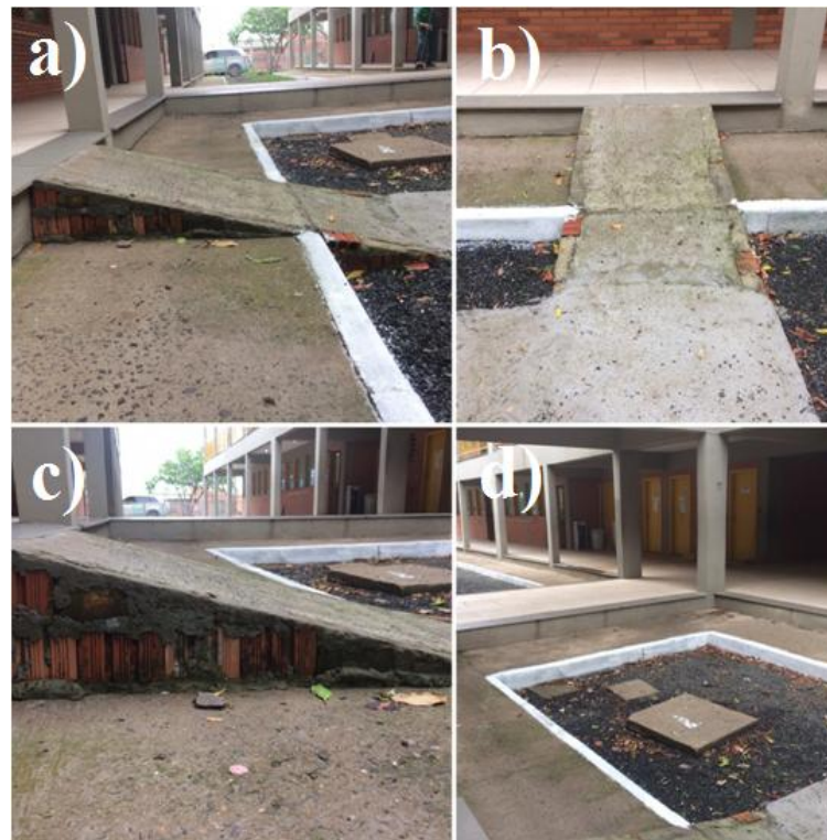
Figura 34 - a) Vista lateral da rampa de acesso; b) Vista frontal; c) Vista lateral aproximada; d) Pátio onde a rampa está localizada
