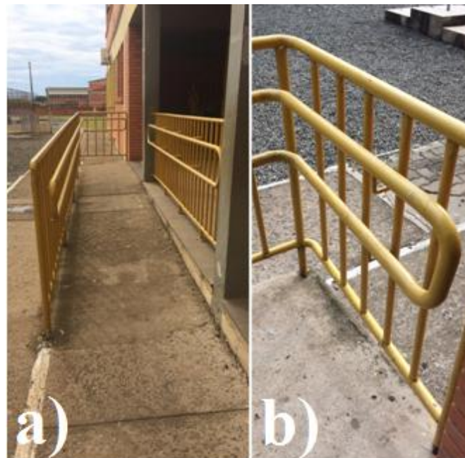
Figura 38 - a) Vista frontal da rampa; b) Corrimão de duas alturas
