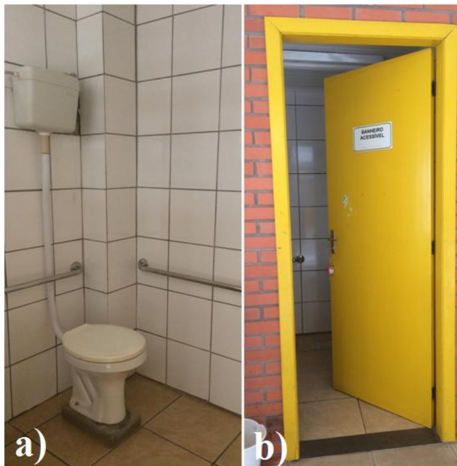
Figura 39 - a) Vista do sanitário; b) Porta de entrada do sanitário
