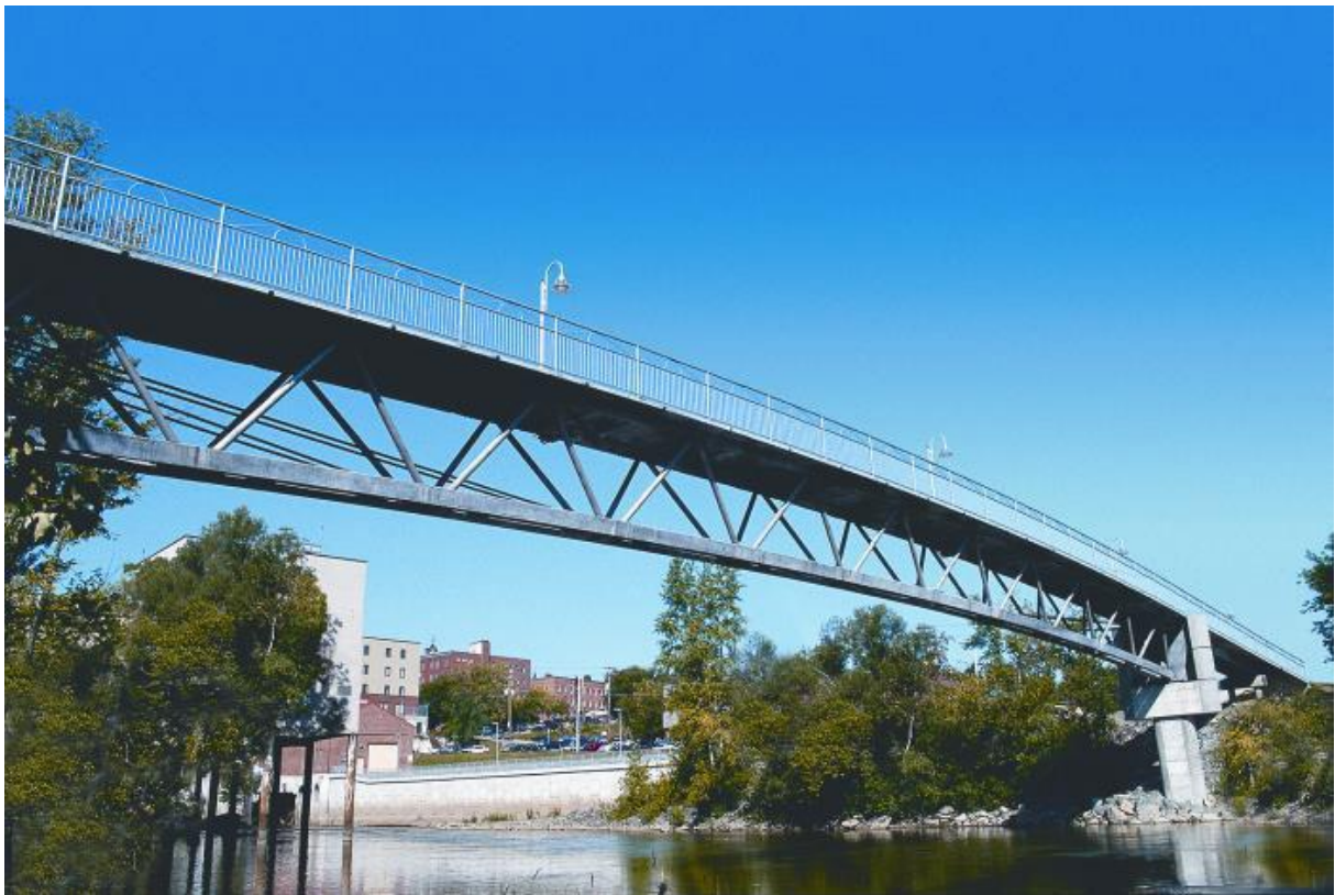
Figura 1 - Passarela construída com uso do concreto de pós-reativo, na cidade de Sheerbrooke, Canadá
