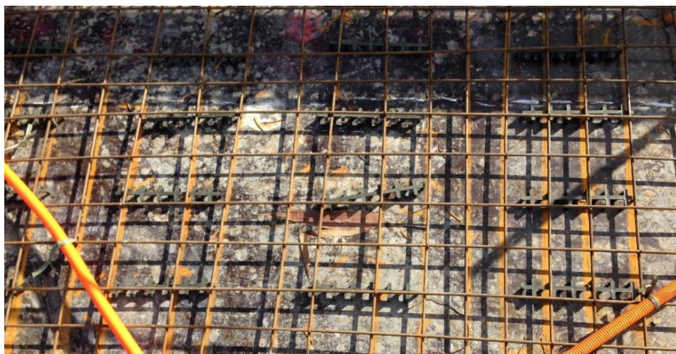
Figura 16 – Quadrante com espaçadores colocados a cada 20cm
