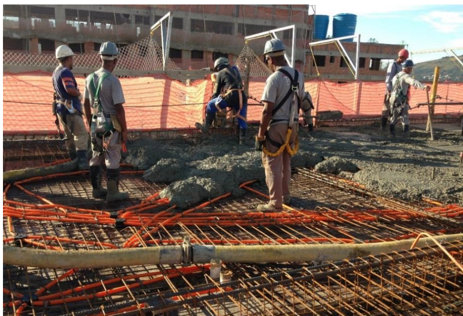
Figura 14 – Momento da concretagem da 1ª laje
