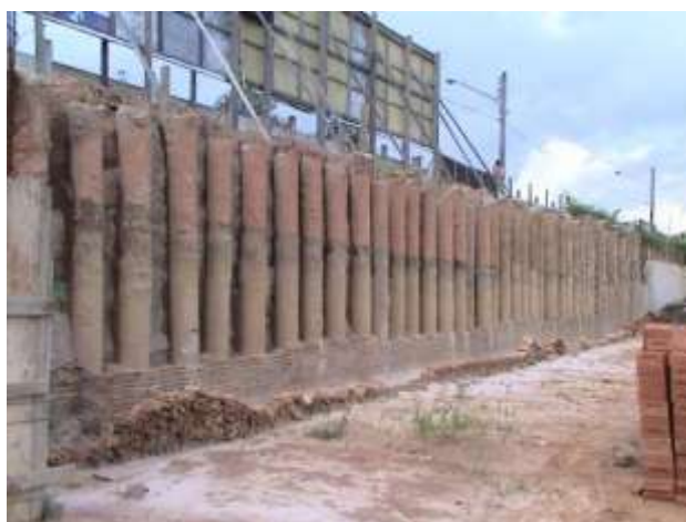
Figura 25 – Estacas Raiz
