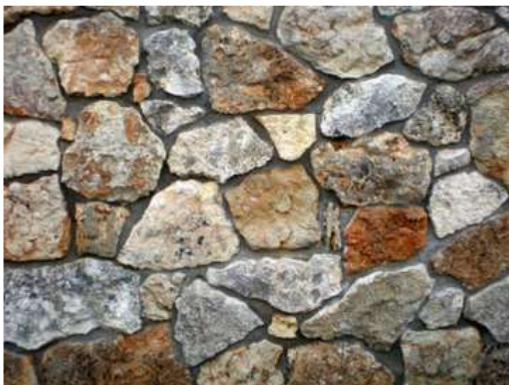
Figura 10 – Muro de pedra argamassada
