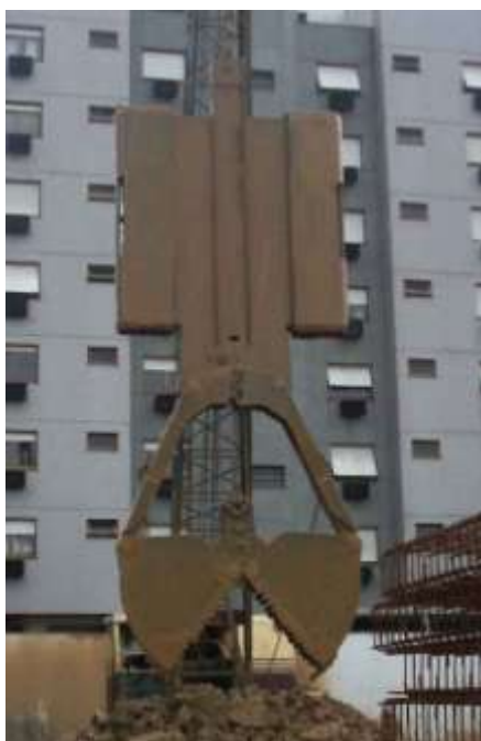
Figura 26 – Ferramenta de Escavação tipo Clam-Shell
