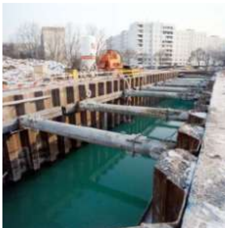
Figura 24 – Estacas estroncadas
