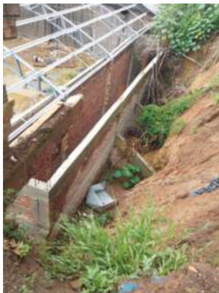
Figura 6 – Muro provisório construído na divisa e reconstrução do galpão atingido
