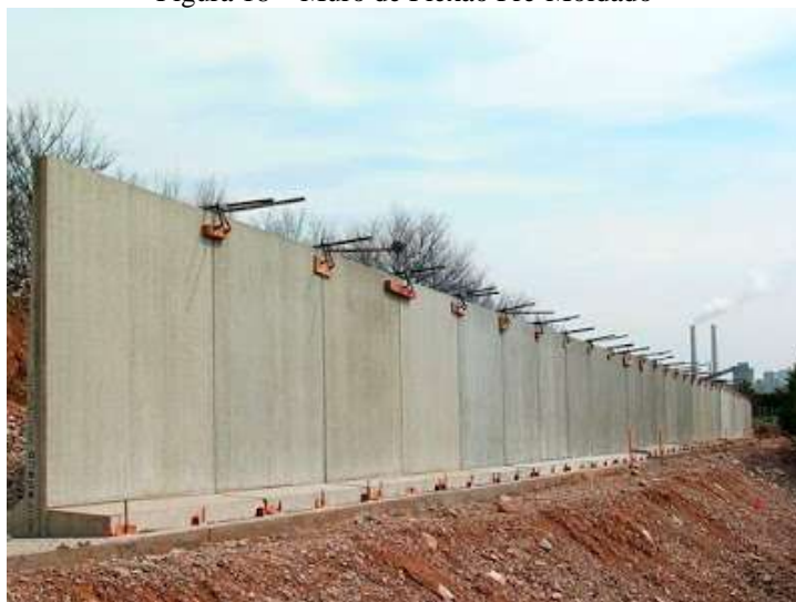
Figura 18 – Muro de Flexão Pré-Moldado
