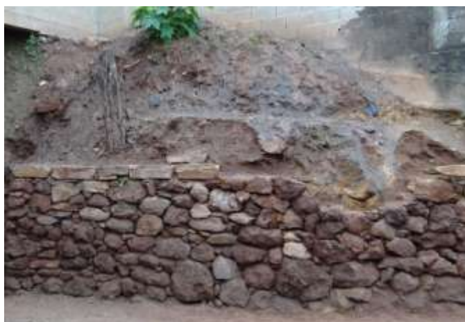
Figura 9 – Muro de contenção de pedra seca
