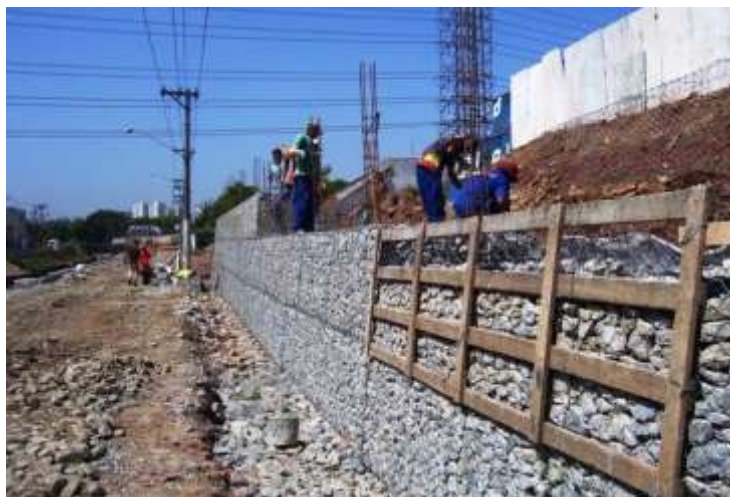
Figura 13 – Montagem de gabião caixa
