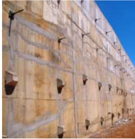
Figura 19 – Cortina Atirantada
