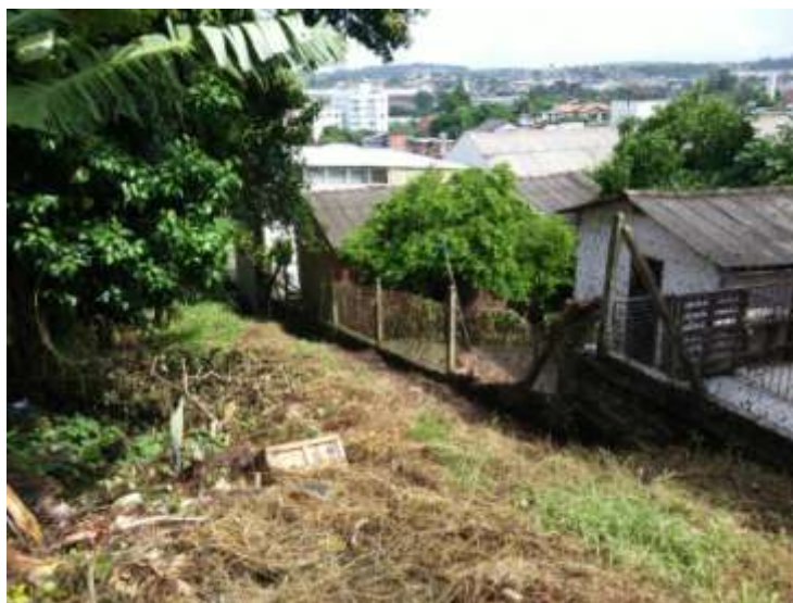
Figura 7 – Único acesso de máquinas ao local de construção da estrutura
