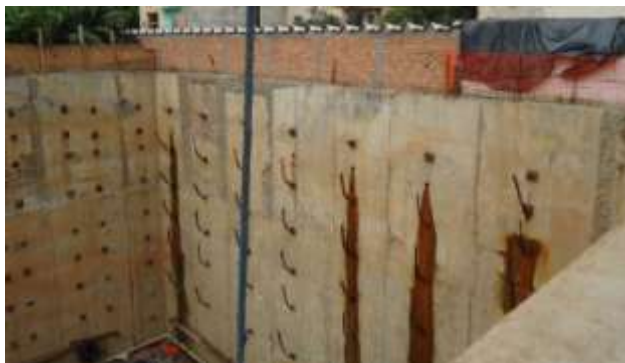
Figura 27 – Parede de Diafragma Atirantada
