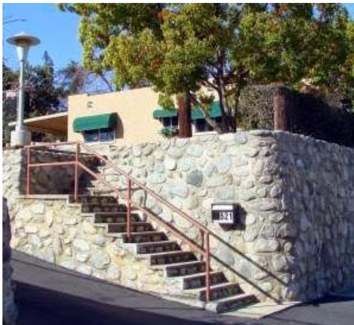
Figura 11 – Muro de concreto ciclópico
