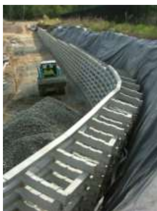
Figura 14 – Montagem de muro tipo crib-wall
