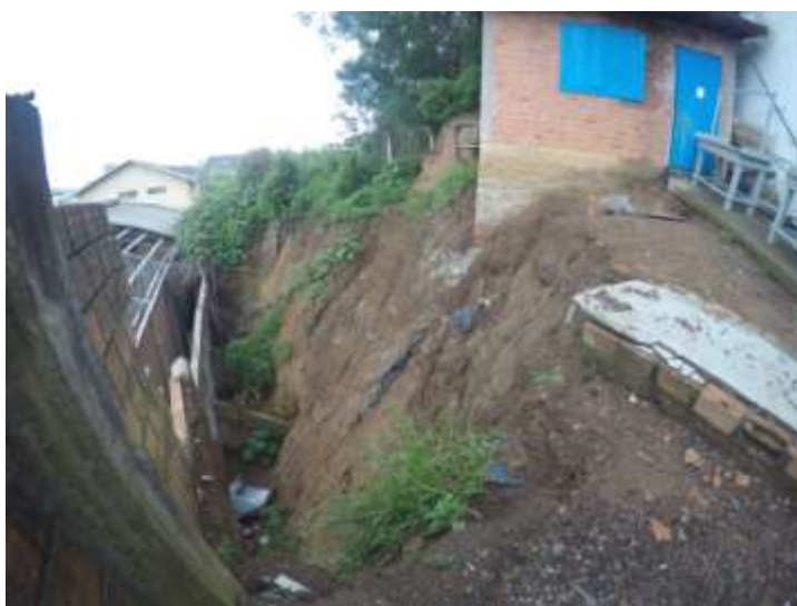
Figura 4 – Encosta formada após queda de muro
