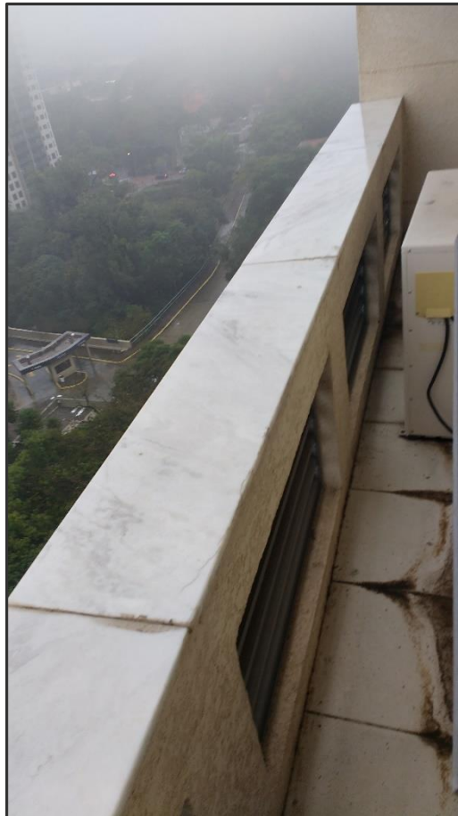
Figura 13 – Laje técnica de apoio aos aparelhos de sala comercial
