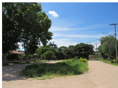
Figura 133 – Avenida General Flores da Cunha, no Loteamento Villa Balneária Belém Novo, sem pavimentação. Fonte: Pessoal da autora, 2017.
