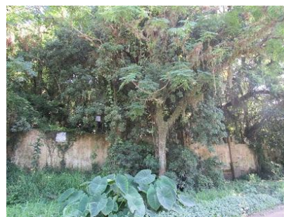
Figura 145 – Residência visualmente em estado de conservação precário e à venda na margem do Guaíba, na Praia do Veludo.
