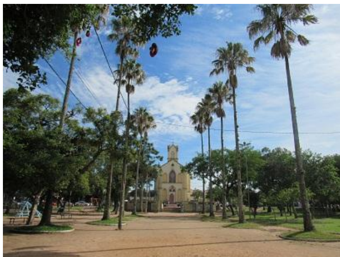
Figura 135 - Praça e Igreja Nossa Senhora de Belém após reformas. Fonte: Pessoal da autora, 2017.
