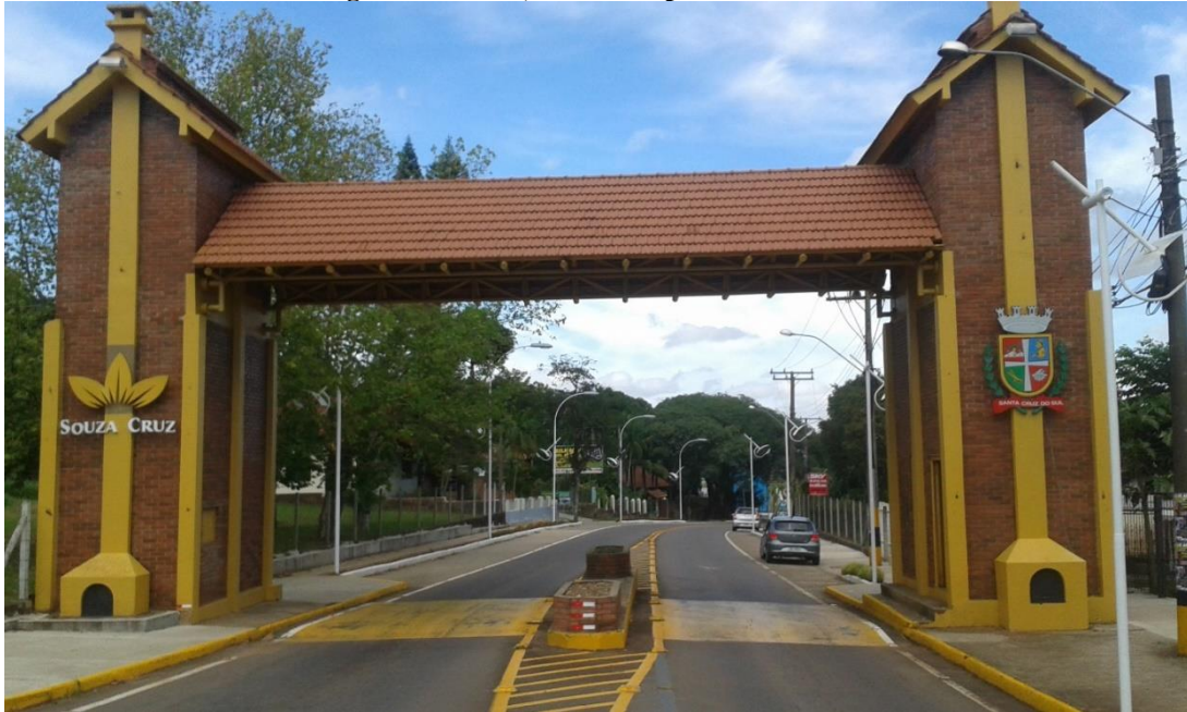
Figura 3 – Pórtico de entrada da cidade de Santa Cruz do Sul, representando a estrutura de estufas de secagem de tabaco, utilizadas pelos fumicultores 7
