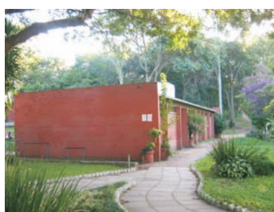
Prédio destinado a depósito e aulas de ginástica (que não funcionam)
