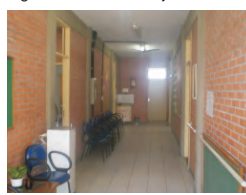
Fig. 20 - Corredor acesso principal
