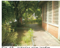
Fig. 18 - exterior com jardim
