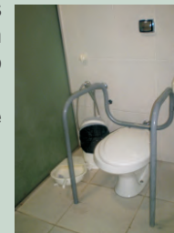
Fig.10 - Barras de apoio
