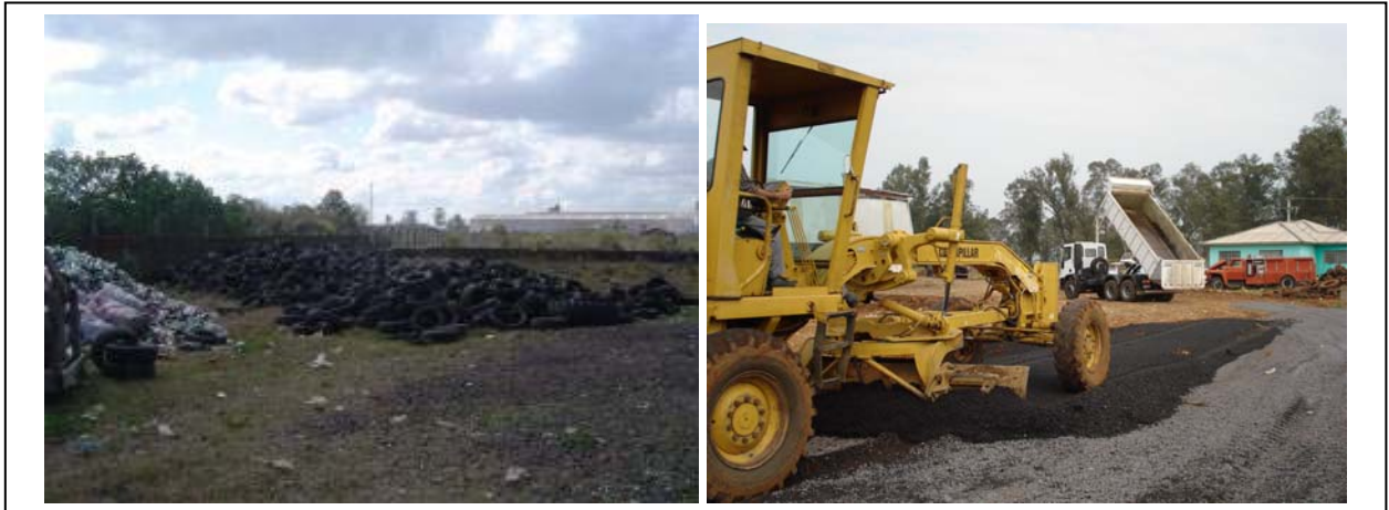
Figura 4 – Antes e depois do nivelamento do solo
