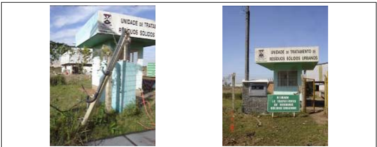
Figura 6 – Antes e depois do concerto do poste elétrico
