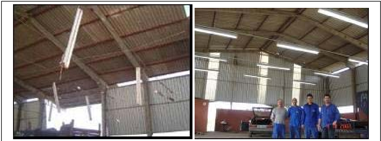
Figura 10 – Antes e depois da recuperação da elétrica
