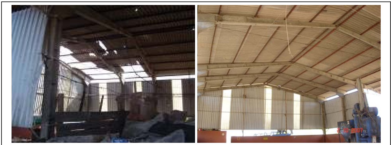
Figura 8 – Antes e depois do conserto do telhado Fonte: Autor do trabalho
