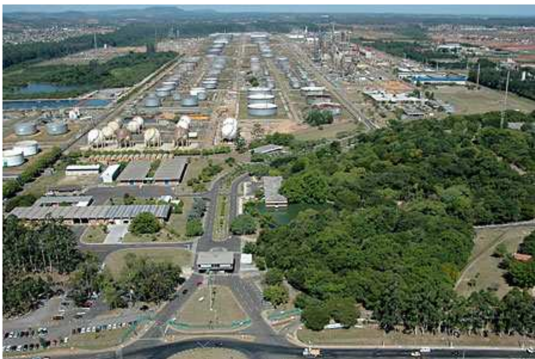
Figura 02 - Fotografia aérea da Alberto Pasqualini – Refap S/A.
