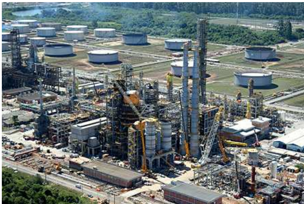
Figura 05 – Uma das maiores obras de engenharia na América Latina
