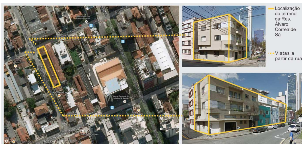
Figura 3.1 - Res. Álvaro Correa de Sá - vista aérea do terreno e vistas a partir da rua
