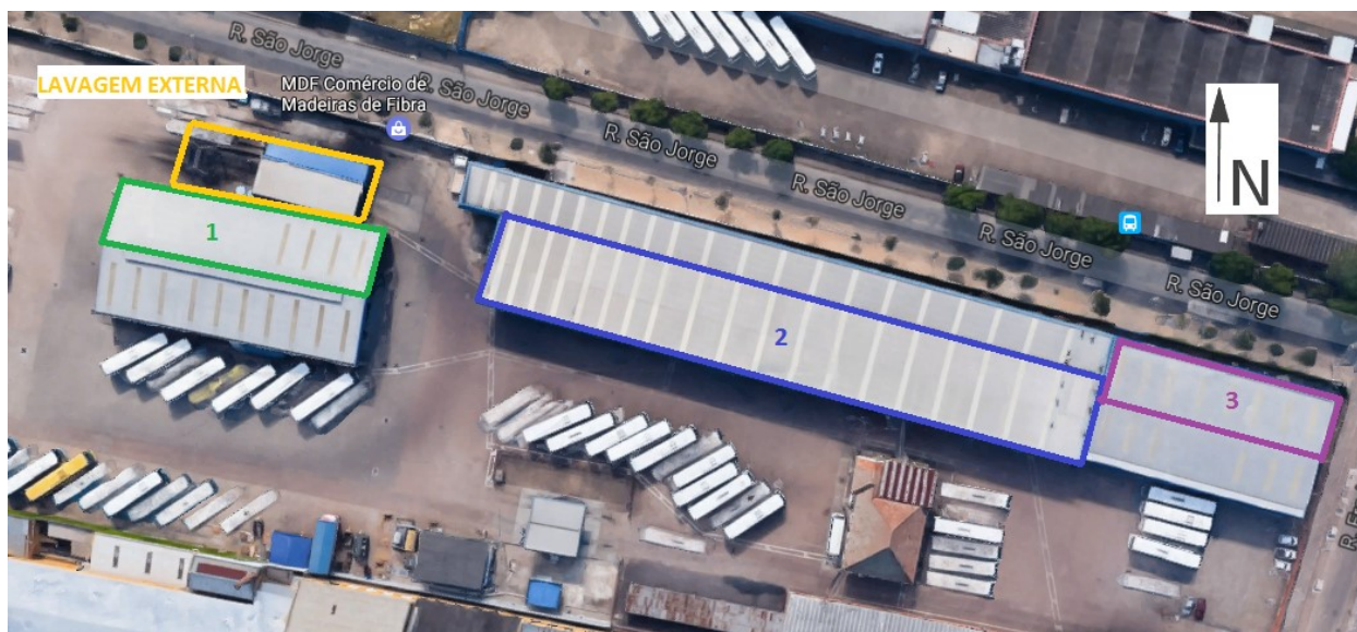
Figura 5.1 – Áreas disponíveis para instalação de painéis.(1) Borracharia, (2) Oficinas e (3) Logística.
