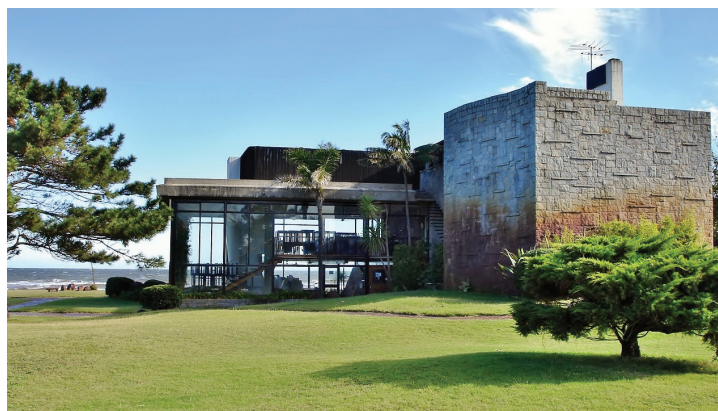
FIGURA 6 — Vista posterior antes da intervenção, com o anexo revestido em pedra.
