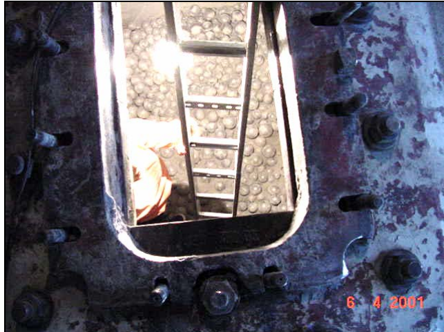
Figura C.7 – Detalhe da porta de entrada da câmara 1 usada para coleta de amostras e manutenção do moinho.
