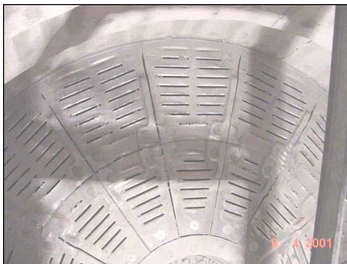
Figura C.4 – Grelha intermediária (k1/k2) do moinho de bolas: vista interna da câmara 1.
