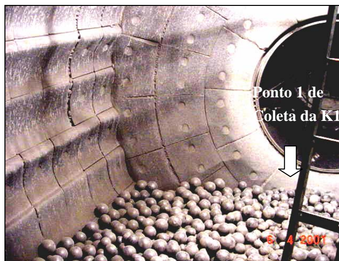
Figura C.3 – Alimentação: entrada da câmara 1.
