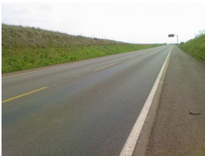
Figura 5.6 – Asfalto em bom estado
