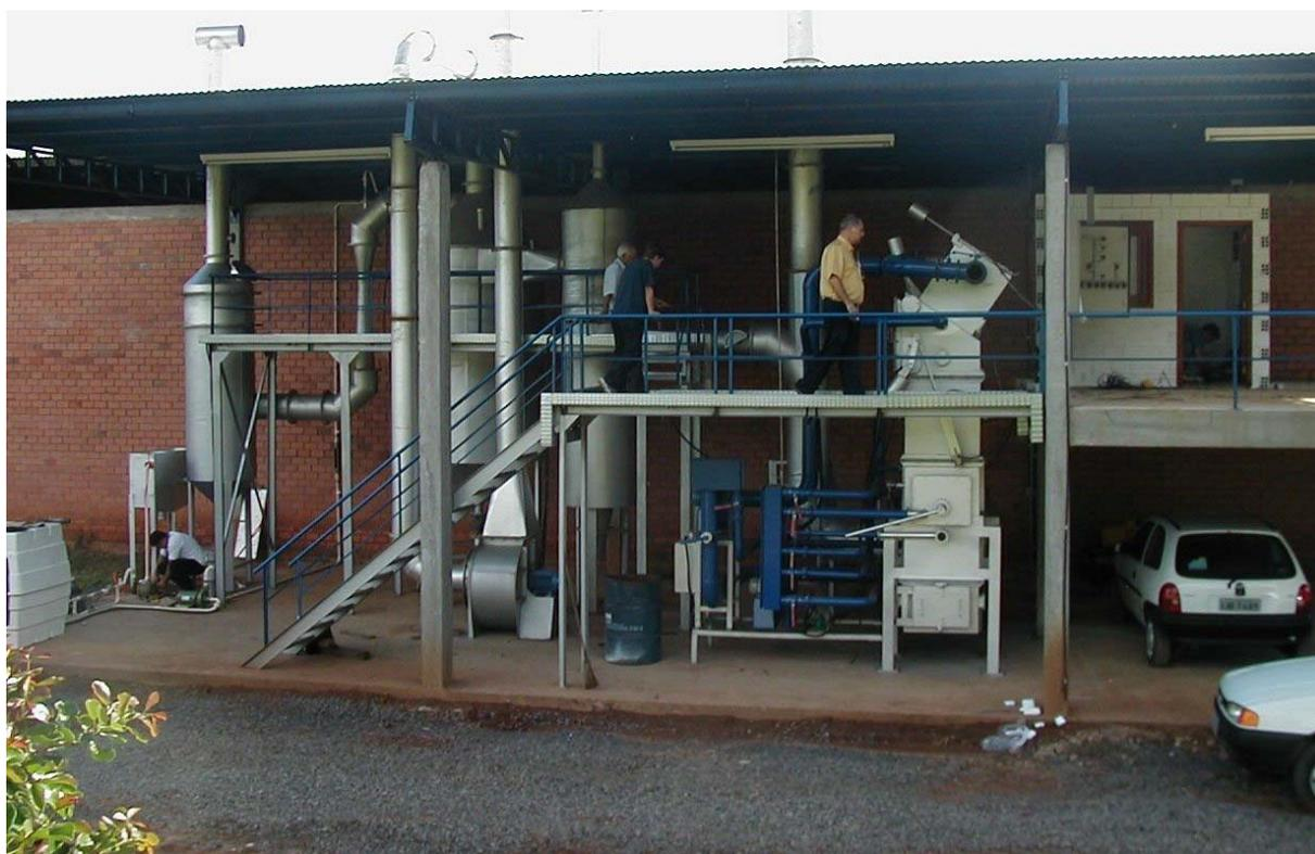
**Figura 2.5:** Planta piloto para tratamento térmico de resíduos de couro
