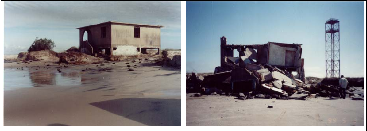
Figura 59 - Casa do faroleiro do farol da Conceição, a direita, antes de cair (01 abril 1998), a esquerda, queda depois de intensa erosão (abril 1999).
