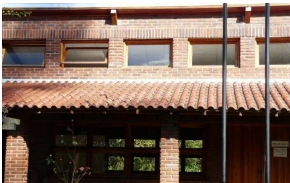
Figura 24 – Janelas superiores da fachada Norte
