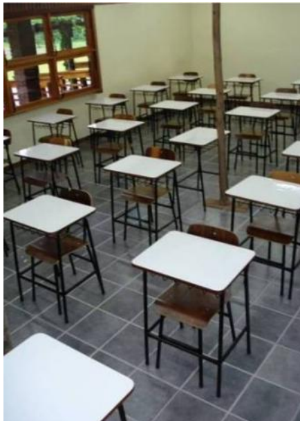
Figura 27 – Piso interno da edificação
