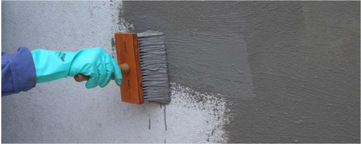
Figura 28 – Aplicação da impermeabilização
