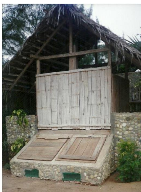
Figura 5 – Sistema com duas câmaras de uso alternado
