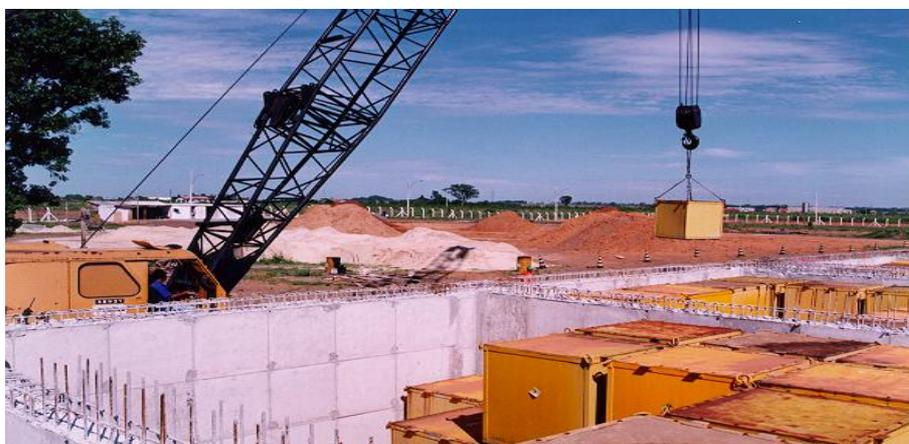
Figura 2: Confinamento dos rejeitos tratados com barreira de engenharia.
