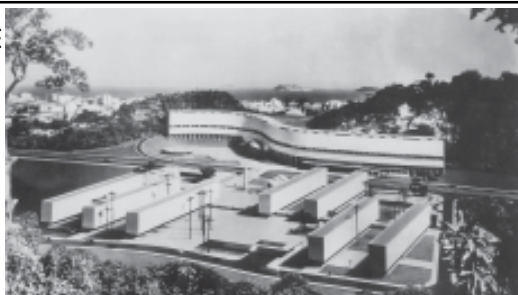
Conj. res. da Gávea, 1952/67/NE Affonso Eduardo Reidy Av. Pe. Leonel Franca, s/n Rio de Janeiro
