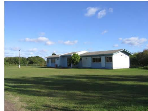
12 - vista da edificação que atende a algumas aulas do Curso de Biologia Marinha e Costeira (sala de aula e laboratório)
