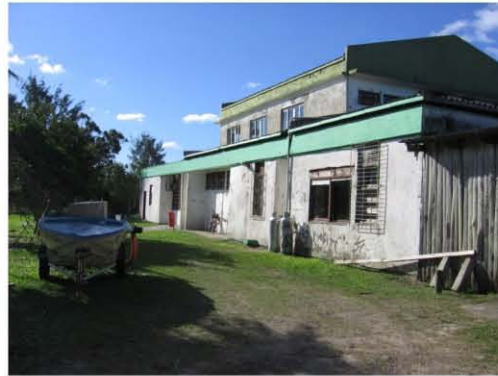
8 - vista dos fundos do prédio administrativo/pesquisa
