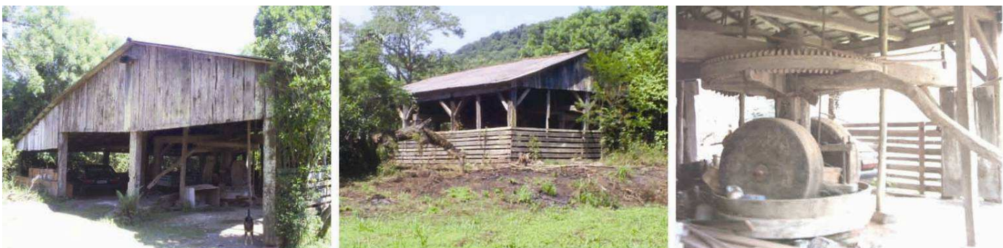
Vistas do galpão e do moinho
