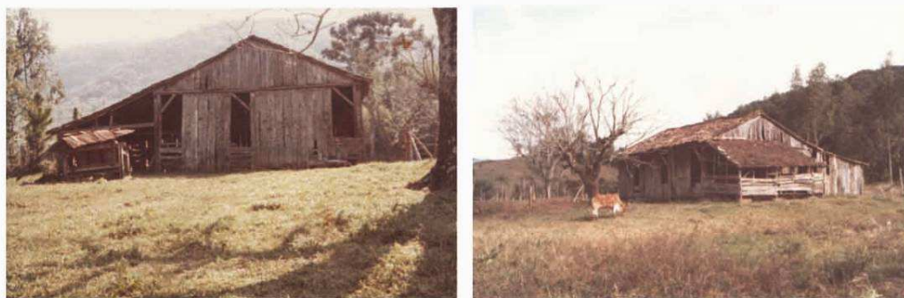
Fotos da década de 1980. Frente e ffundos antes da reforma.
