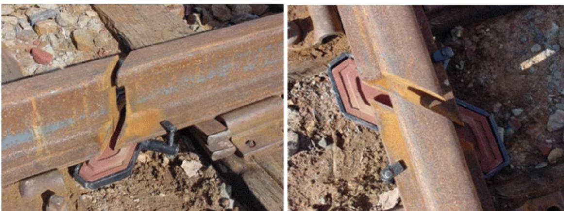
Figura 3.2 – Alinhamento do trilho e colocação do molde.
