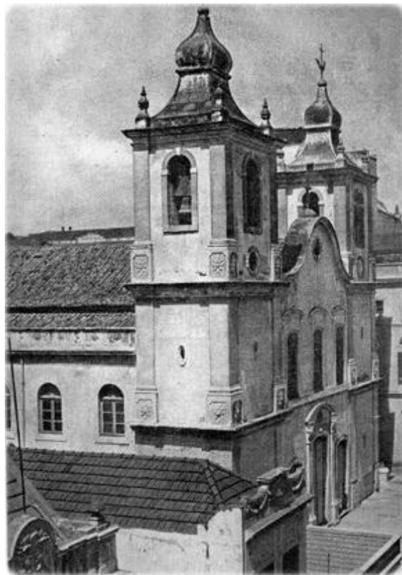
Fotografia de autor desconhecido Igreja Matriz de Nossa Senhora do Rosário , erguida entre 1817 e 1827 e demolida em 1951, Porto Alegre Acervo Museu de Porto Alegre Joaquim José Felizardo
