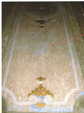
Registro do Restauro realizado na Igreja Nossa Senhora da Conceição em 2009 Prospecção em pintura do intradorso do Arco-Cruzeiro Acervo do arquiteto Lucas Volpato
