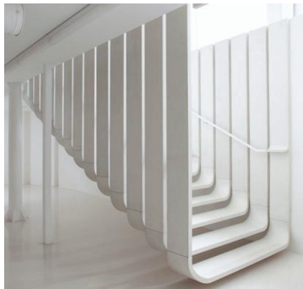
Figura 7 – Exemplo de utilização de CPR na construção de uma escadaria residencial [Fonte: adaptado de LAFARGE].
