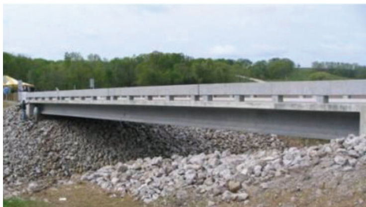
Figura 2 –Ponte rodoviária de Mars Hill, nos EUA [Fonte: adaptado de FHWA, 2013].
