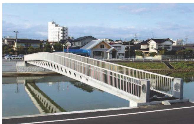
Figura 3–Ponte/passarela Sakata-Mirai, no Japão [Fonte: adaptado de LAFARGE].
