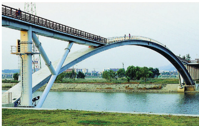
Figura 4–Ponte/passarela Seonyu-kyo, na Coréia do Sul [Fonte: disponível em: https://ksamedia.osu.edu/item/38198 ].
