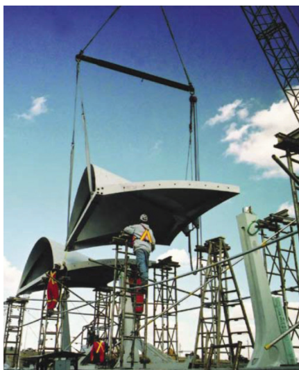
Figura 5 – Montagem das coberturas da estação de trens de Shawnessy, no Canadá, utilizando elementos de casca pré-fabricados em CPR [Fonte: adaptado de VICENZINO et al., 2005].
