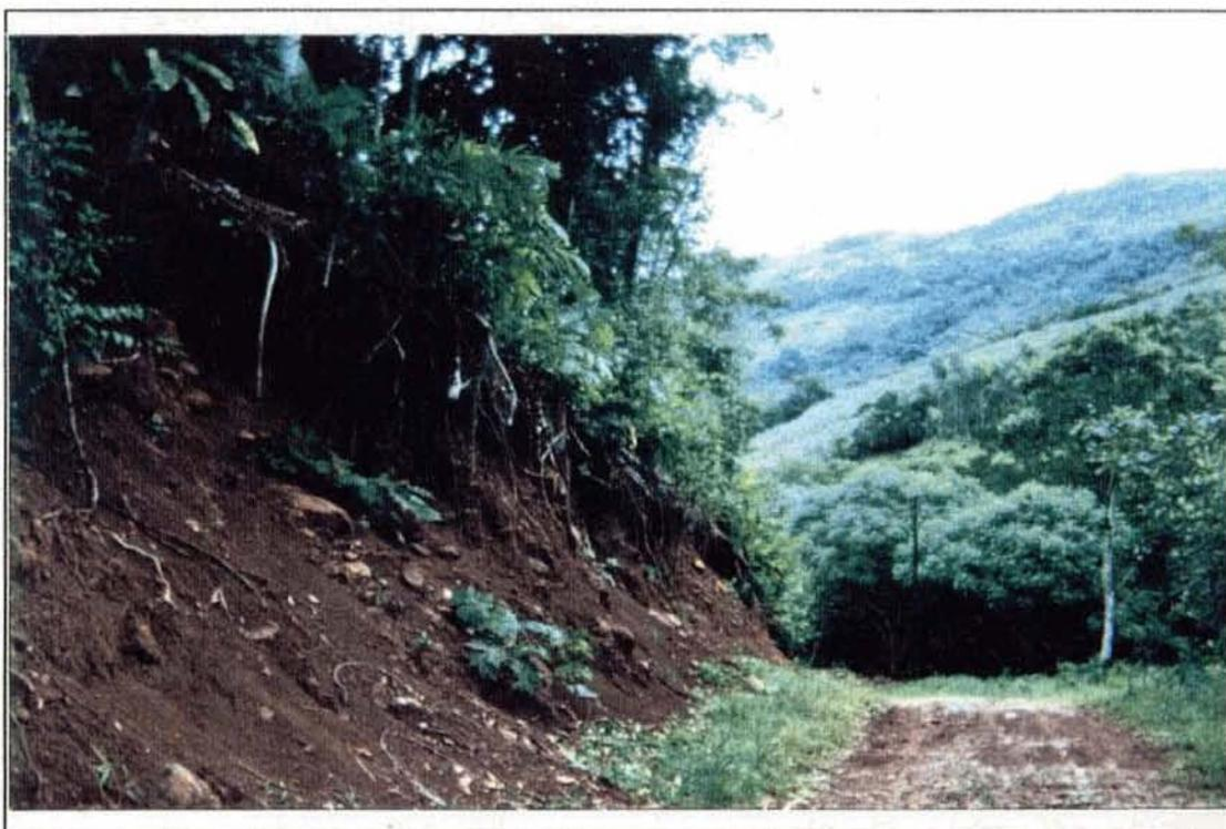
**Foto 6.** Corte de estrada, onde observa-se depósito de colúvio, contendo blocos de basalto irregulares envoltos em matriz argilosa, na localidade de Poço das Andorinhas.
