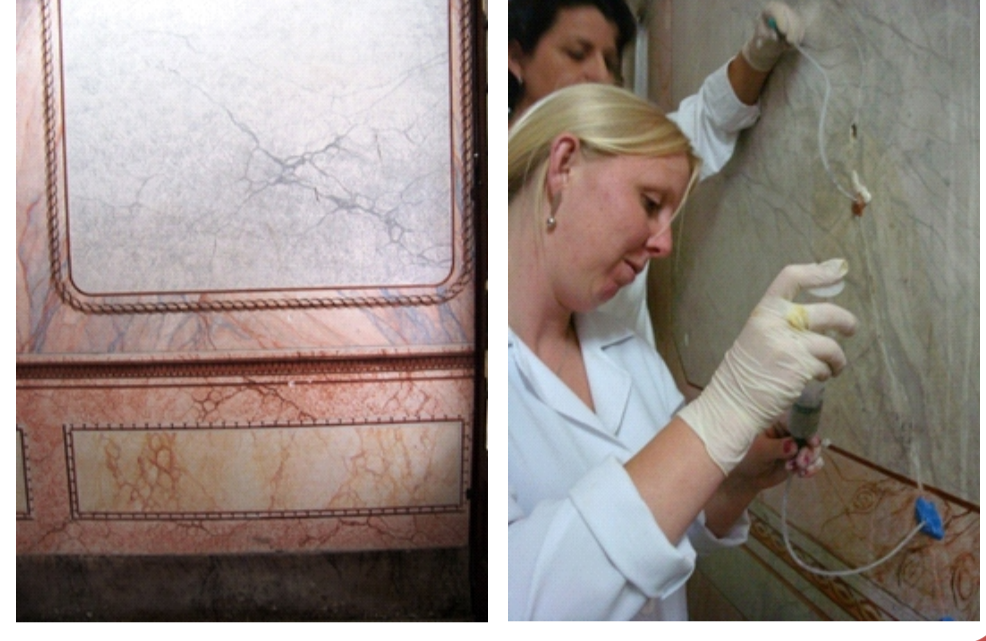
Figura 1: Injeção de argamassa em parede de edificação histórica.
