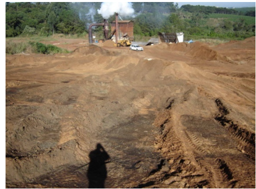
Figura 34 - Depósito de cavaco verde
