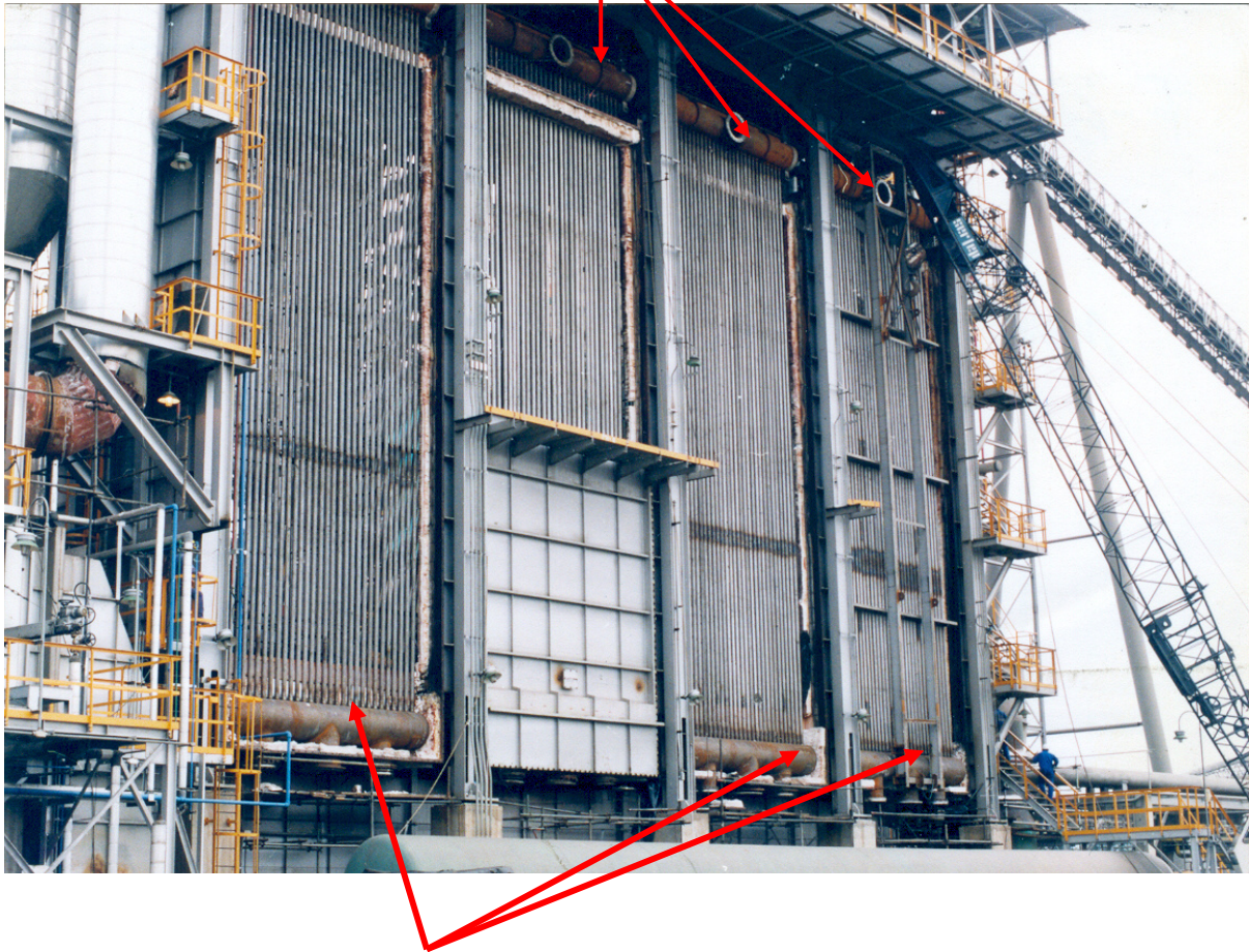
Figura 3.11 - Vista externa do forno sem o refratário e tampas, onde pode ser visualizada a fixação inferior dos tubos [PETROBRAS, 1994].
