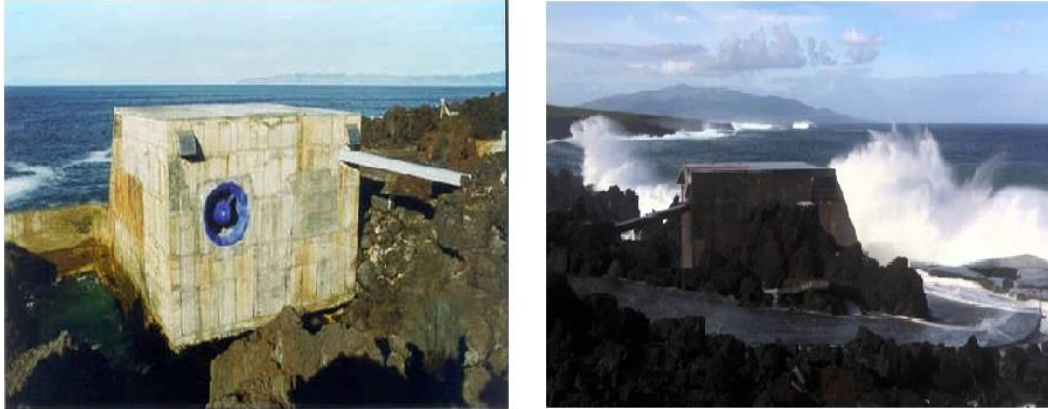
Figura 2.5 – Projeto de dispositivo CAO da Ilha de Pico. (Save Pico Powerplant, 2015)
