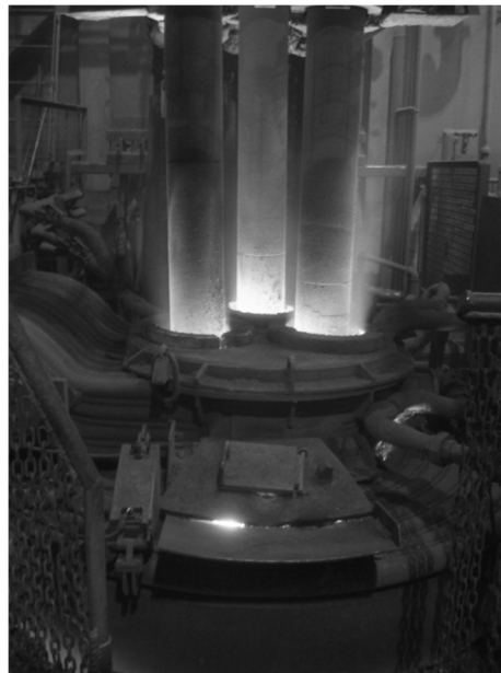
Figura 12 Forno-panela utilizado para o acerto de composição química e de temperatura na produção do aço. Fonte: CORTESIA DE USINA SIDERÚRGICA
