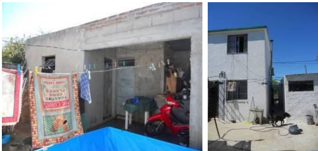
Figura 51: Construcción de dormitorios adicionales - COOP
