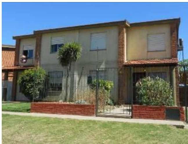
Figura 39: Emprendimiento PPT, tipología dúplex, 3 dormitorios apareadas – marzo 2011
