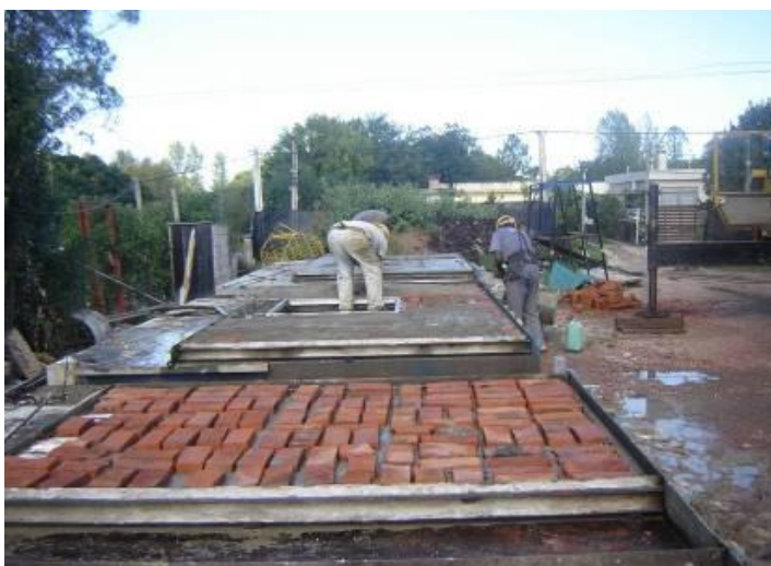
Figura 26: Panel prefabricado realizado en obra
