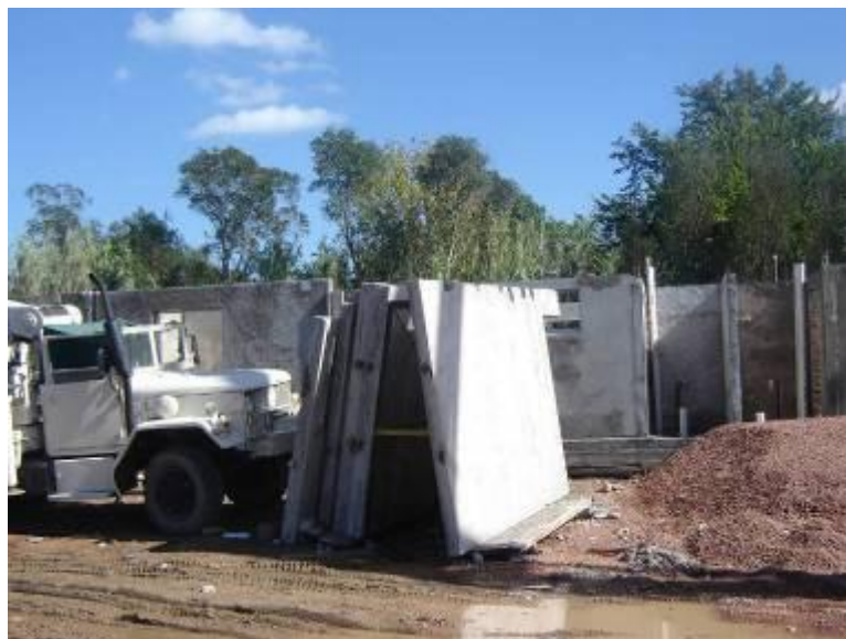
Figura 27: Paneles listos para ser montados
