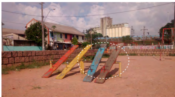
Figura 4.8: Equipamento com pintura precária e ferrugem – Loteamento Santa Terezinha Nota: A linha pontilhada identifica a área danificada.
