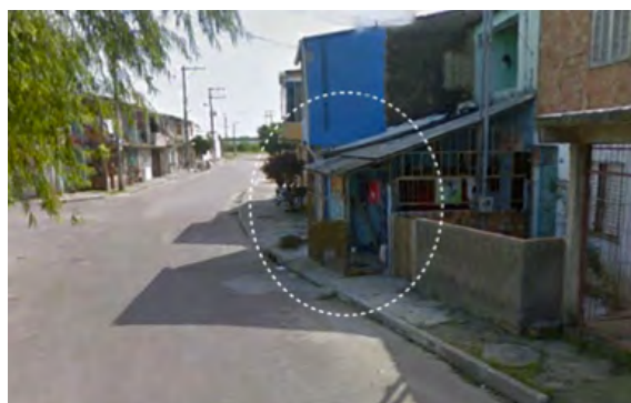
Figura 4.37: Passagem parcialmente interrompida – Loteamento Pampa
