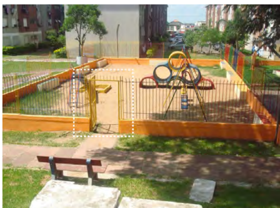
Figura 4.6: Cercamento da pracinha Fernando Ferrari Bloco T
