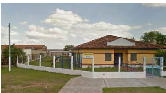
Figura 3.11: Creche comunitária 0 a 12 anos do Loteamento Pampa
