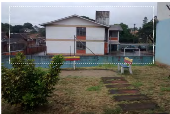
Figura 3.26: Muro junto a Escola Eng. Rodolfo Ahrons
