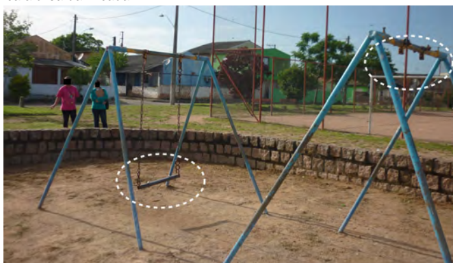
Figura 4.10: Equipamento faltando partes – Vila Tecnológica Nota: A linha pontilhada identifica a área danificada.
