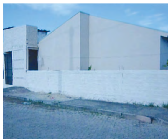
Figura 4.51: Edificação sem janelas
