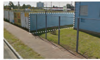
(a) Vista 1 – muro.
