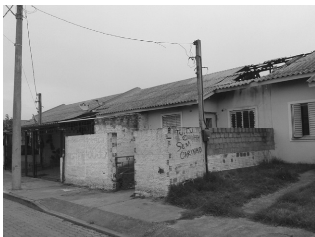
FIGURA 27 | Espaço para garagem na unidade habitacional térrea. Fonte: acervo pessoal (2015).
