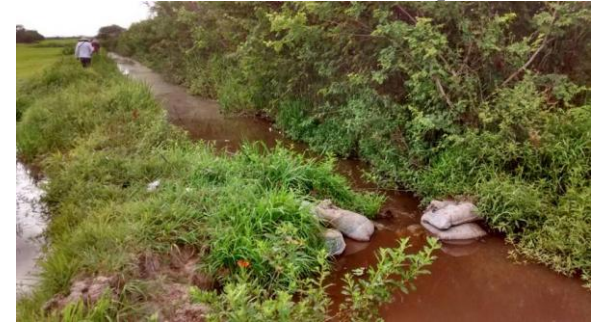
ANEXO D: Estrutura de barramento em canal terciário – Assentamento Filhos de Sepé
