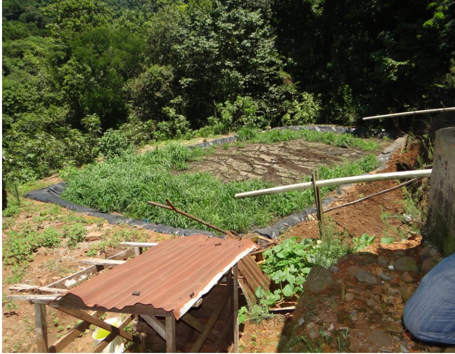
Figura 4: Tanque coletor de resíduo em uma produção de bovinos confinados, o qual está fora de conformidade e necessita de cercamento do entorno.
