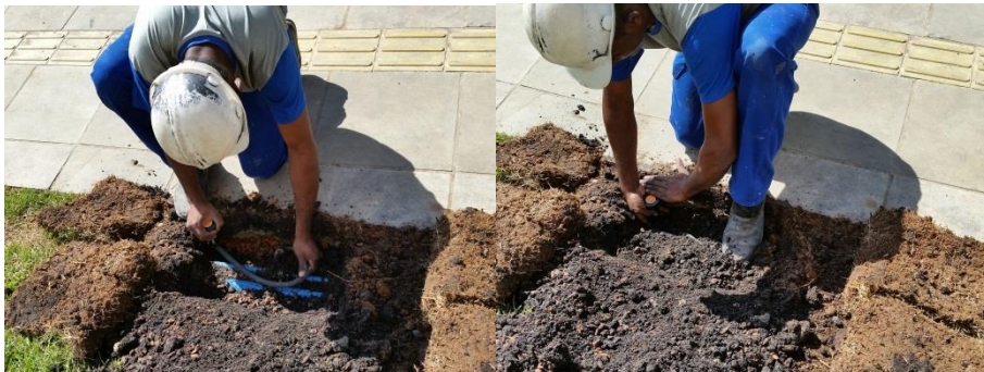
Foto 2- Instalação do aspersor spray, com tubo flexível afastado das bordas do canteiro
