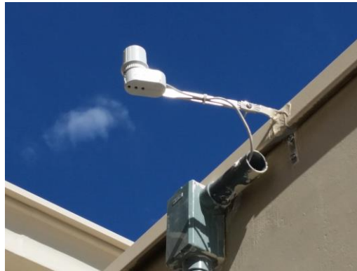
Figura 7. Sensor de Chuva instalado Fonte: Dirce Tremper
