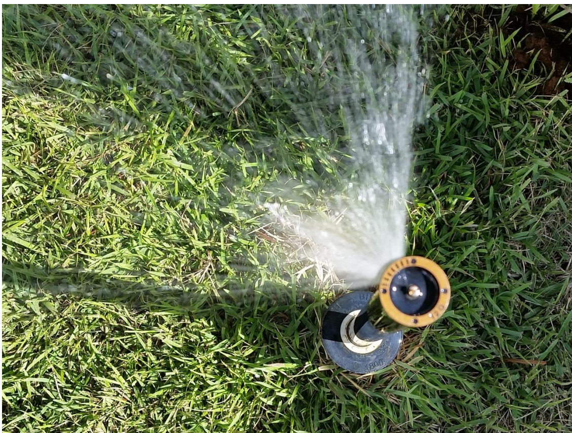
Foto 3- Aspersor do tipo spray em funcionamento; Projeto Boulevard Laçador
