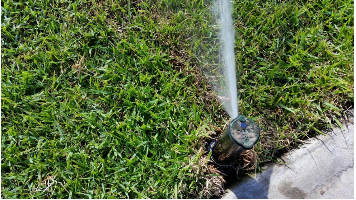
Foto 4- Aspersor do tipo rotor em funcionamento; Projeto Boulevard Laçador
