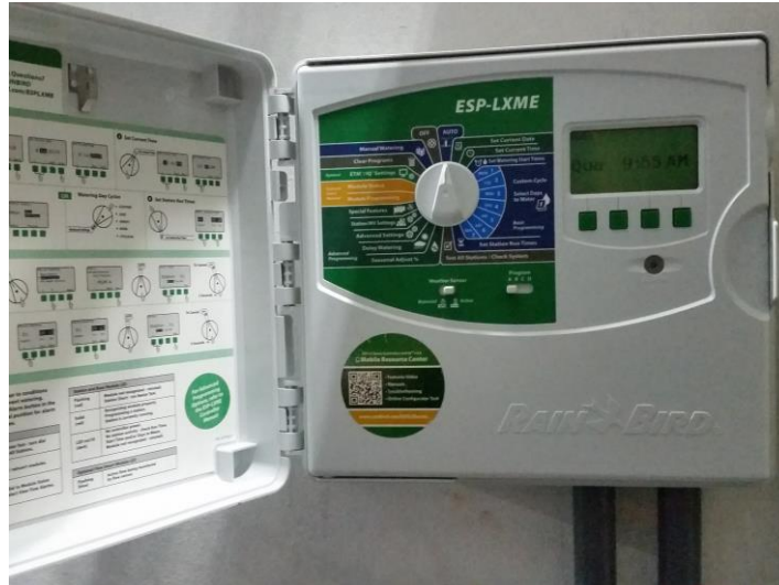
Figura 3. Controlador ESP-LXME modular Rain Bird® Fonte: Dirce Tremper
