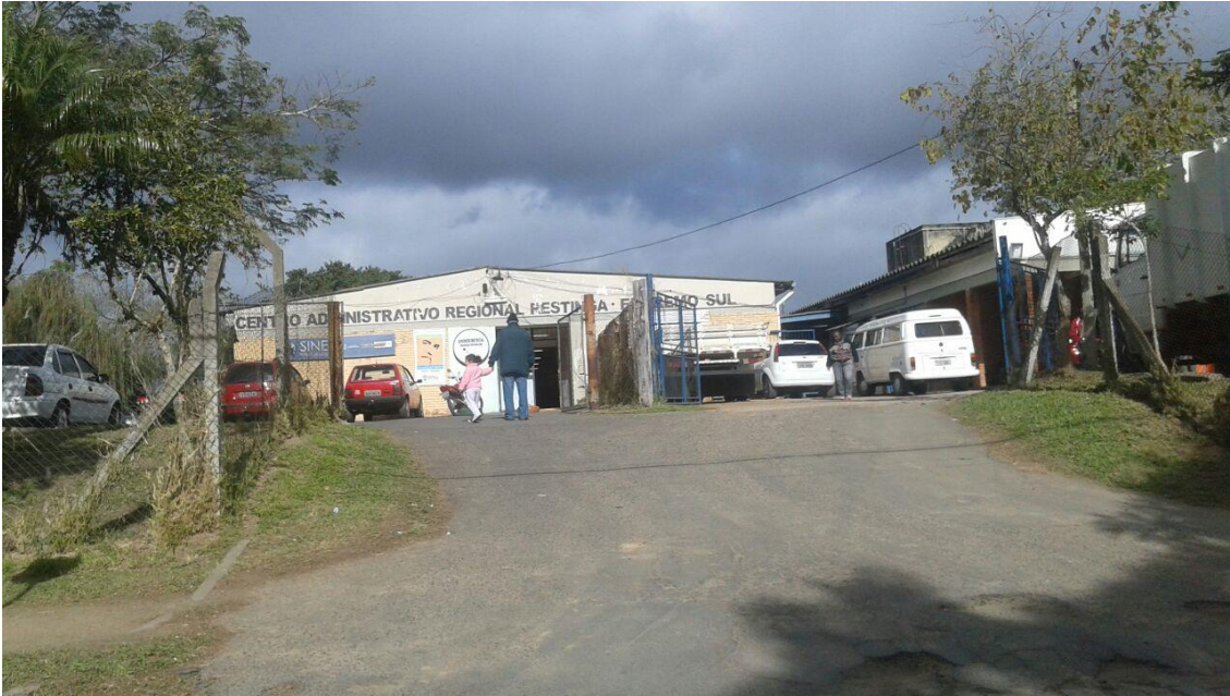
Figura 20 – Centro Administrativo Regional Restinga.
