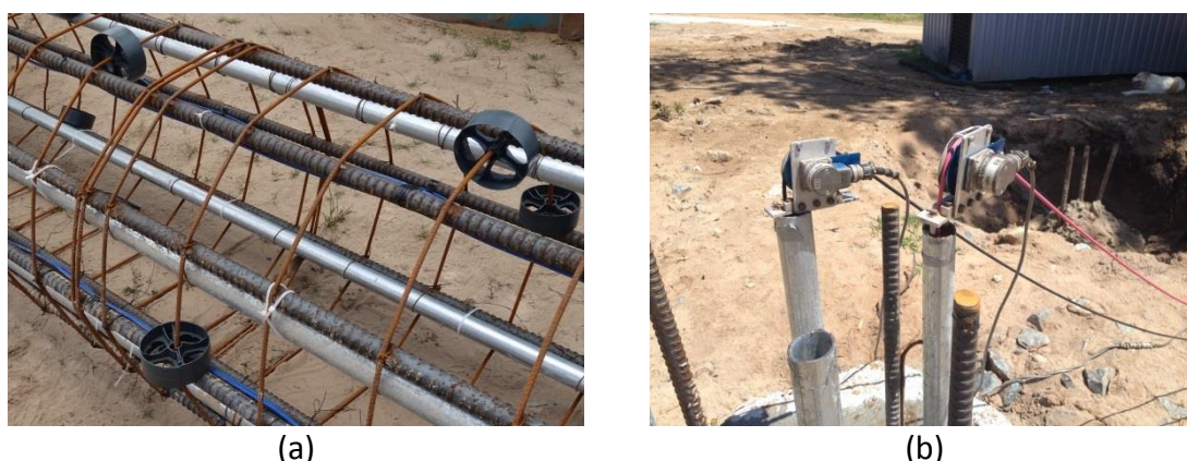
Figura 5. 18 – a) posição dos tubos no interior da estaca para ensaio de Cross Hole e em b) execução do ensaio tipo Cross Hole
