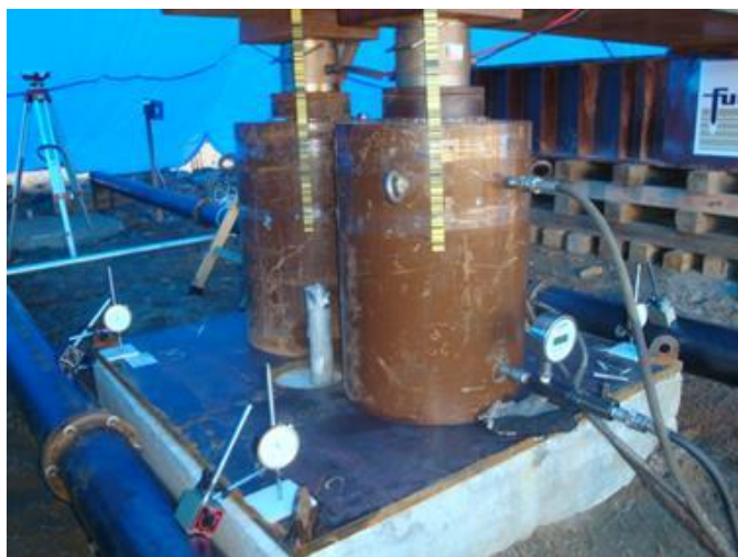
Figura 2. 31 - Detalhe da distribuição dos medidores no topo da estaca
