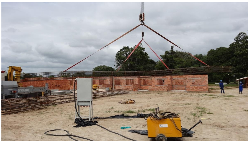
Figura 5. 11 – Detalhe de içamento da armadura da estaca teste
