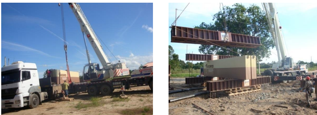
Figura 6. 3 – Montagem do sistema de reação
