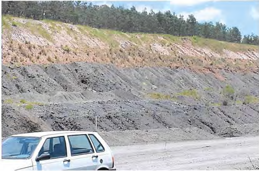
Figura 4.14: Depósito de bota-fora presente no limite sul da área de estudo.
