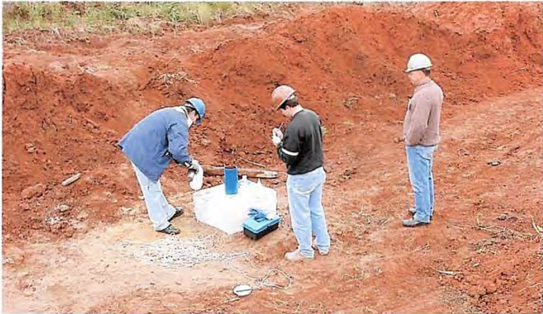
Figura 4.27: Piezômetros de monitoramento.
