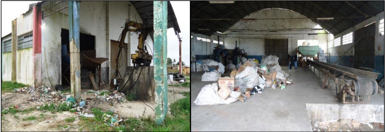
Figura 8. Central de triagem desativada.
