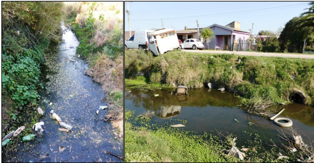
Figura 4. Córregos poluídos com resíduo e esgoto.
