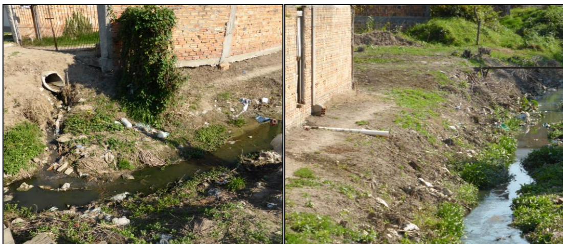
Figura 5. Lançamento de esgoto nos cursos de água.
