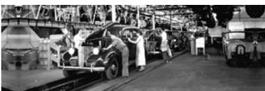
Figura 2: Linha de montagem sugerida por Henry Ford, na produção de carros. FONTE: [https://pt.wikipedia.org/wiki/Linha\\_de\\_montagem](https://pt.wikipedia.org/wiki/Linha_de_montagem)
