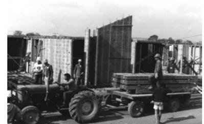
Figura 83: Transporte dos painéis executados no terreno - fáceis de carregar, sem grandes deslocamento de material. FONTE: Vitruvius, 154.02, ano 13, out. 2013
