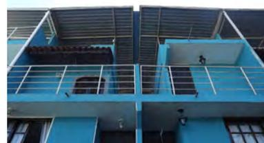
Figura 75: Nas habitações 9, 10 e 12 foi executada uma laje para proteção das esquadrias, ao invés do telhado.
