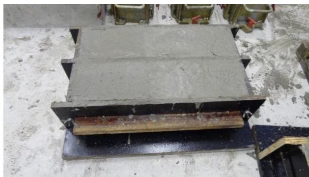
Figura 41: Vigas recém concretadas.
