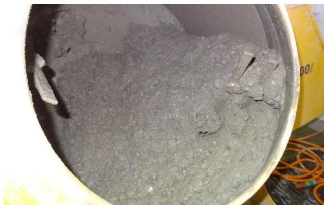
Figura 36: Aparência do concreto na betoneira.
