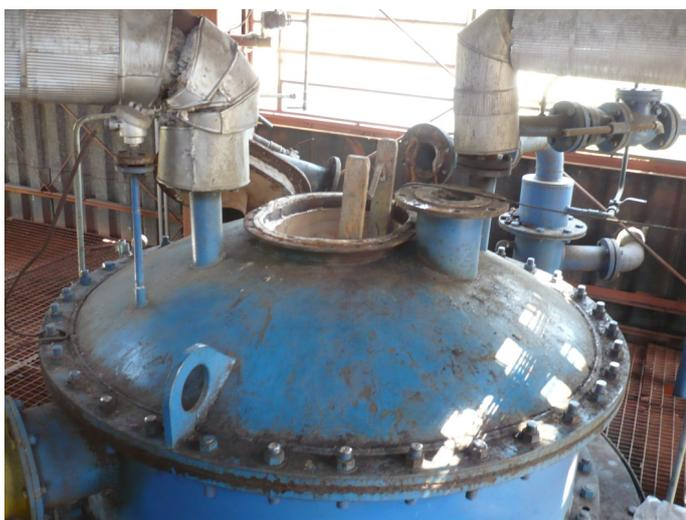
**Figura 3.1.** Parte superior (tampa) do gaseificador de leito fluidizado borbulhante estudado.
