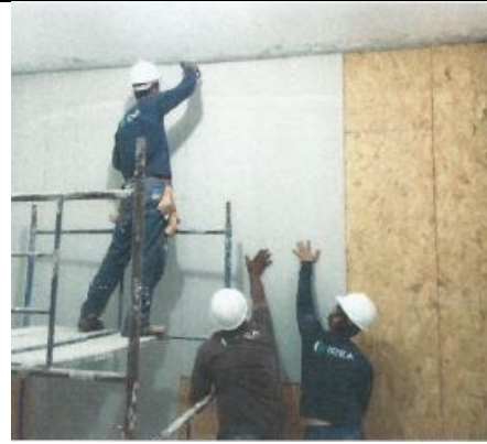
Figura 47 – Montagem de parede protótipo
