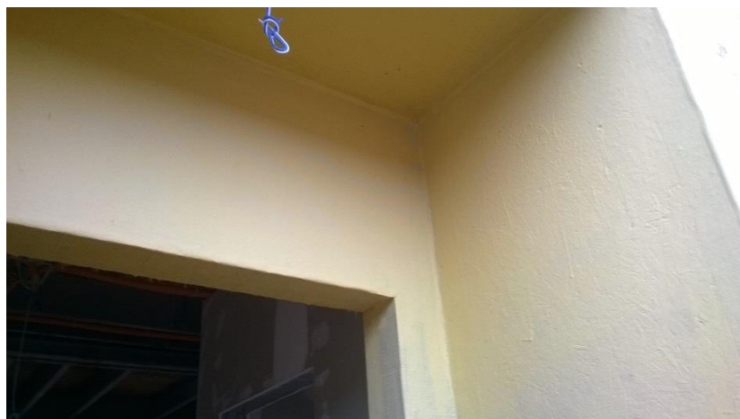
Figura 41– Resultado final após aplicação das 2 demãos
