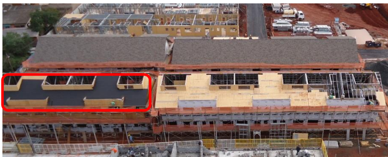
Figura 27 – Telhamentos executados e em execução
