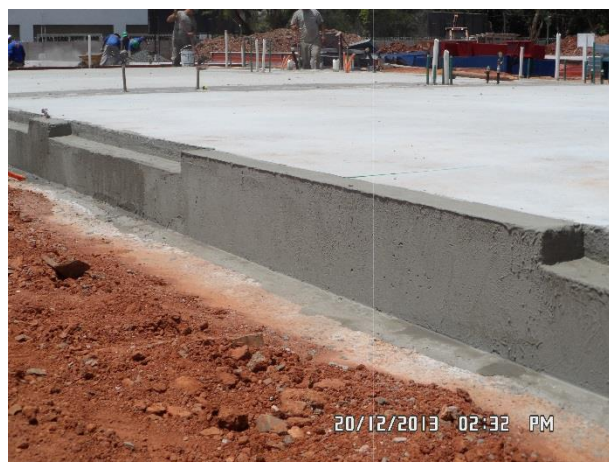
Figura 19 – Vista da superfície do radier impermeabilizado com material cimentício
