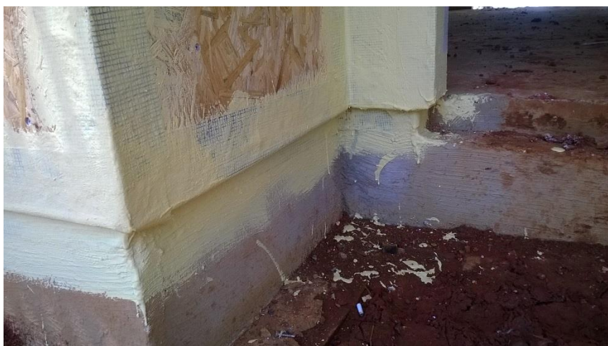
Figura 39 – Detalhes de reforços em cantos 90°
