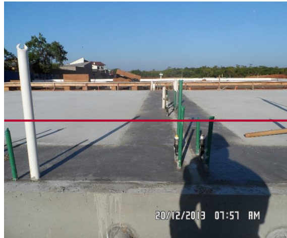
Figura 18 – Vista geral do radier acabado, ressaltando a posição das instalações
