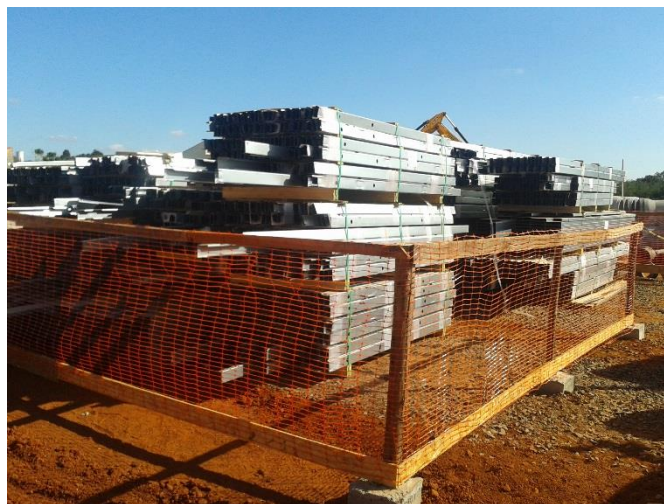
Figura 23 - Estocagem das guias e montantes a serem utilizados nos painéis estruturais desmontados
