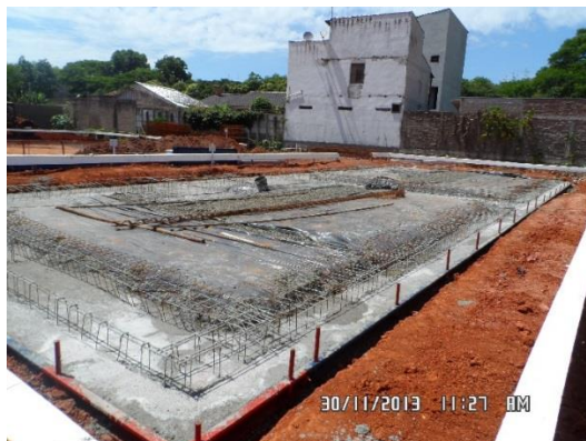
Figura 15 - Concretagem da base do radier
