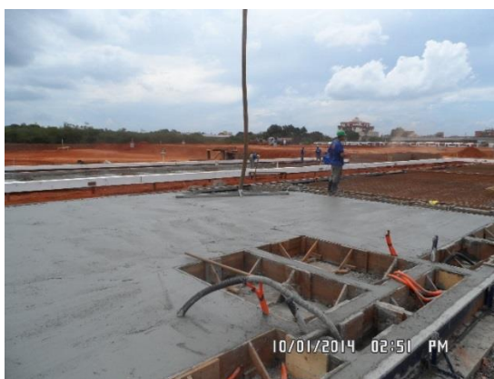
Figura 16 – Detalhe dos rebaixos do radier para colocação das tubulações
