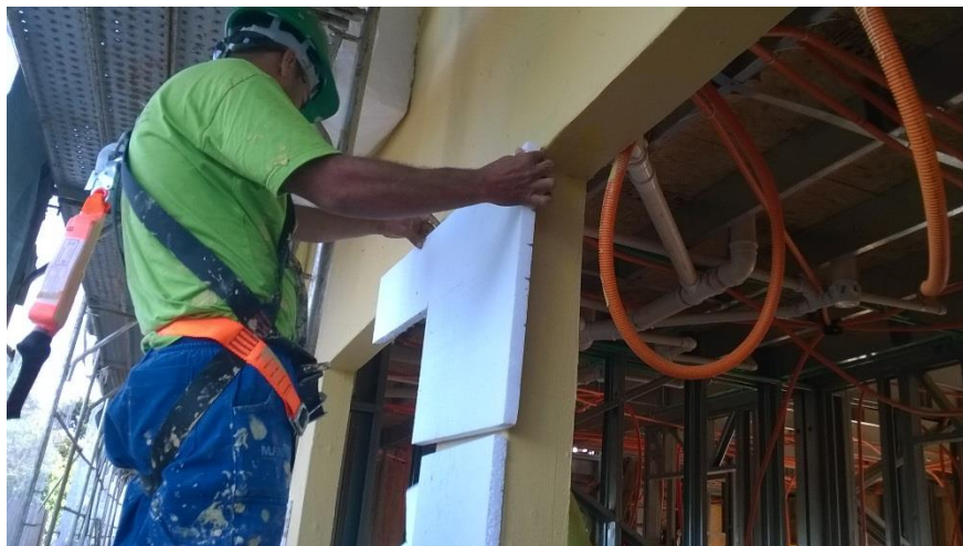
Figura 43 – Fixação das placas de EPS
