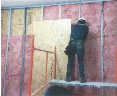
Figura 47 – Montagem de parede protótipo
