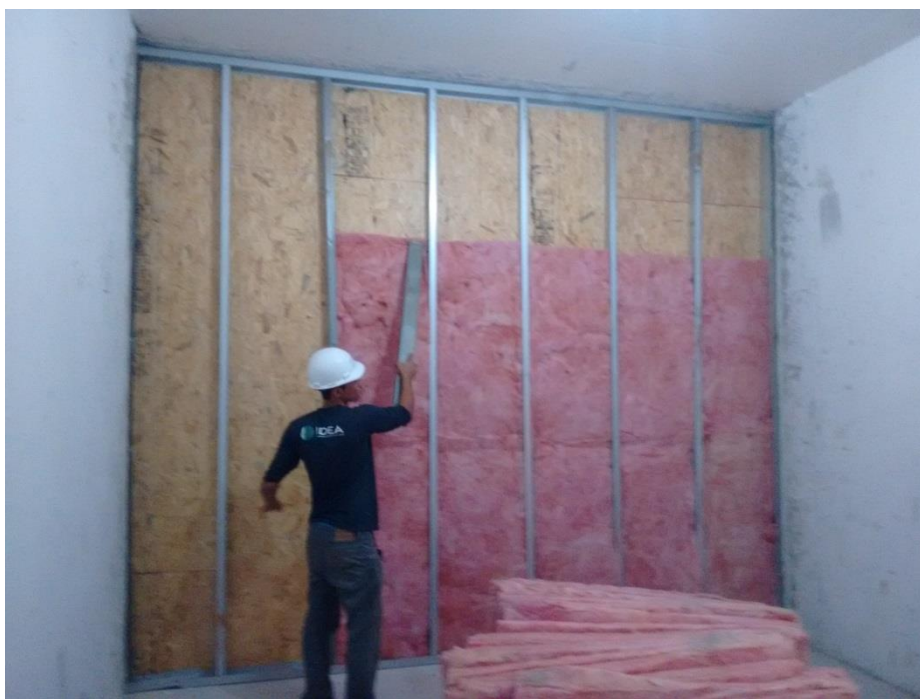
Figura 36 – Aplicação de lã mineral em parede de LSF
