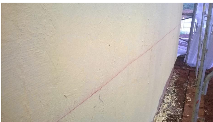
Figura 42 – Linha de início para fixação das placas de EPS
