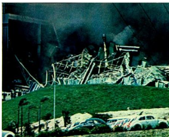
Figura 8 – Desabamento do pavilhão ao meio dia
