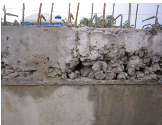
Figura 14 – Ninhos de concretagem em pré-moldados
