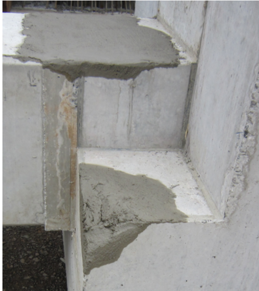
Figura 17 – Reparos em pré-moldado
