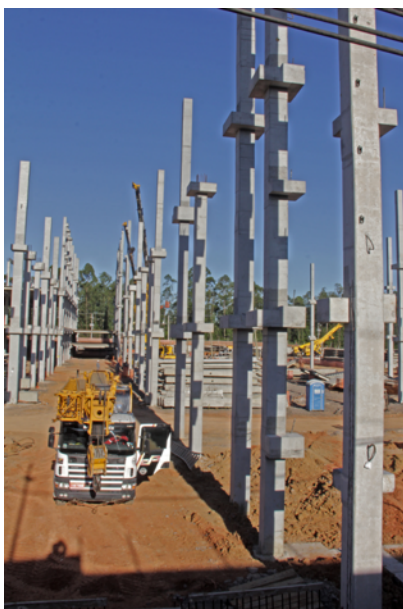
Figura 6 – Exemplo de pilares da edificação
