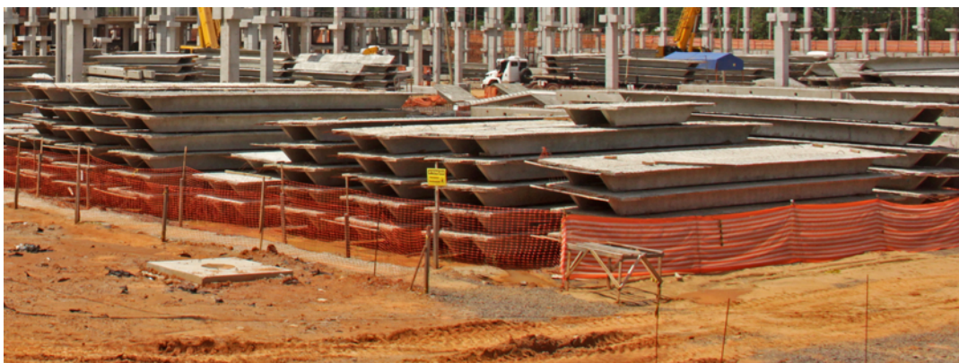
Figura 8 – Exemplo de lajes da edificação
